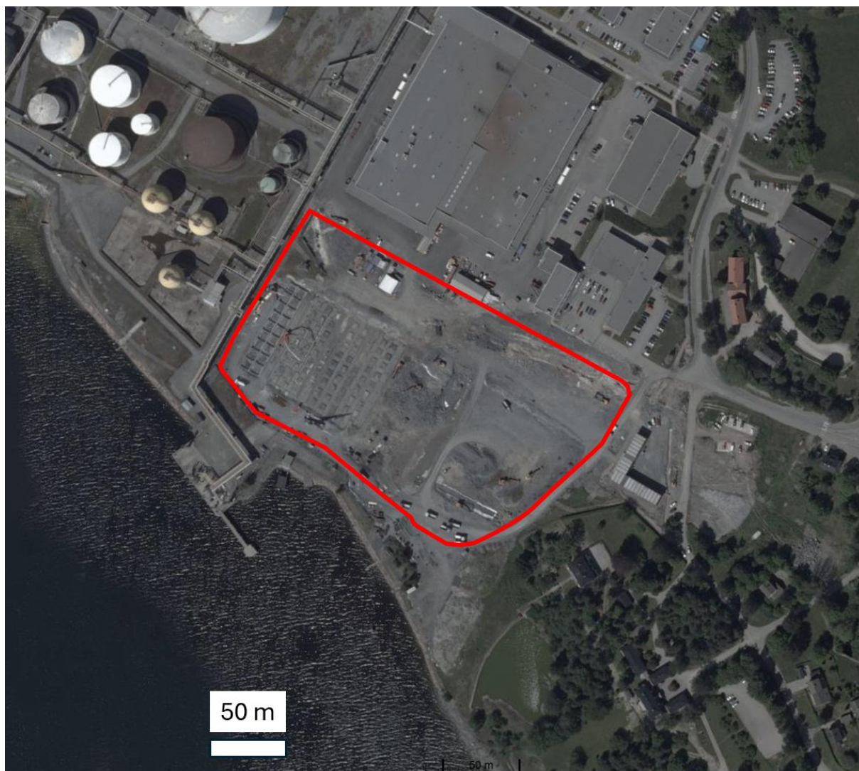
Figur 11: Flyfoto av eiendommen fra 2007. Bygninger 621, 622 og 641 er allerede synlige nord for undersøkelsesområdet. Fundamentering av bygninger 623 og 624 er i gang på undersøkelsesområdet. Fjell er synlig på nordsiden av det, i midten og hel på grensen til høyre. Tankanlegget mot vest er uendret.
