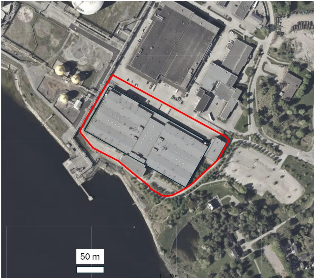
Figur 14: Flyfoto av eiendommen fra 2024. Dagens tilstand av undersøkelsesområdet og omgivelsene.
