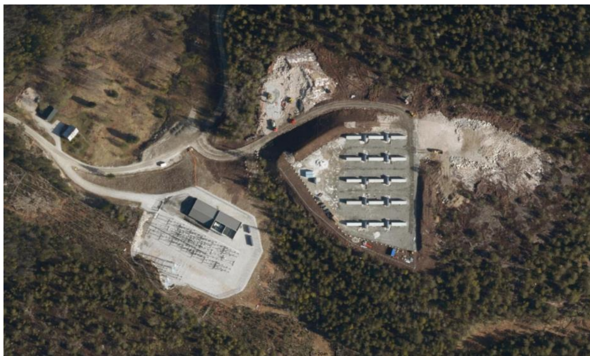
Figur 13: Flyfoto av undersøkelsesområdet fra 2022. Bygging av bitcoinsenteret er i gang som senere er demontert. Åsen er sprengt ned og planert, og skråninger ble utformet rundt omkring. Nord for DRA01 er et område hvor fjell blir sprengt ut, mens øst for DRA01 er et område hvor fjell ble blottet (synlig på sørlige delen av området) og sprengsteinutfylling er i gang. Den hvitaktige fargen av bergarten er godt synlig. Andre detaljer er uendret i forhold til flyfoto fra 2021. Kilde: https://kart.finn.no/
