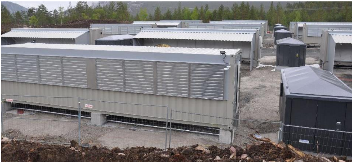
Figur 15: Modulbyggene av det tidligere bitcoinsenteret sett mot sør. Bildet stammer fra juli 2022. Bitcoinsenteret sto på stedet av DRA01, og ble revet før 2024. Som synlig på bildet, sto byggene på steinfylling. Kilde: https://www.drangedalsposten.no/drangedal-everk-vil-tape-pengar-pa-varpet/o/27-164-3009
