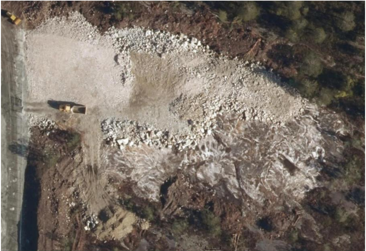
Figur 14: Utklipp fra høyre side av Figur 13, som viser måten av opparbeidelse av anleggsareal. Fjell blir blottet eller sprengt ned, blottet fjell er fortsatt synlig på sørsiden, mens utfylling av sprengstein foregår på nordsiden av dette arealet som senere blir arealet av DRA02. Sprengstein stammer fra det området som ligger mot nordvest for det fremtidige DRA01, vist i Figur 13. Kilde: https://kart.finn.no/
