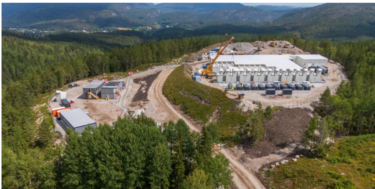
Figur 8: Bygging av DRA01 på flyfoto fra juli 2025, sett mot øst. Skråningen som er dekket med jord har en grønnaktig farge av noe vegetasjon. Planerings- og utfyllingsarbeidet foregår på området av DRA02 i bakgrunnen. Sprengningsarbeidet som var synlig på flyfoto på den venstre delen av bildet i 2022 (jmfør Figur 13), er avsluttet, og sprengstein er brukt i antatt større tykkelse under DRA02 enn DRA01. Kilde: https://www.drangedalsposten.no/forste-byggetrinn-pa-datasenteret-er-straks-ferdig/s/5-164-37104
