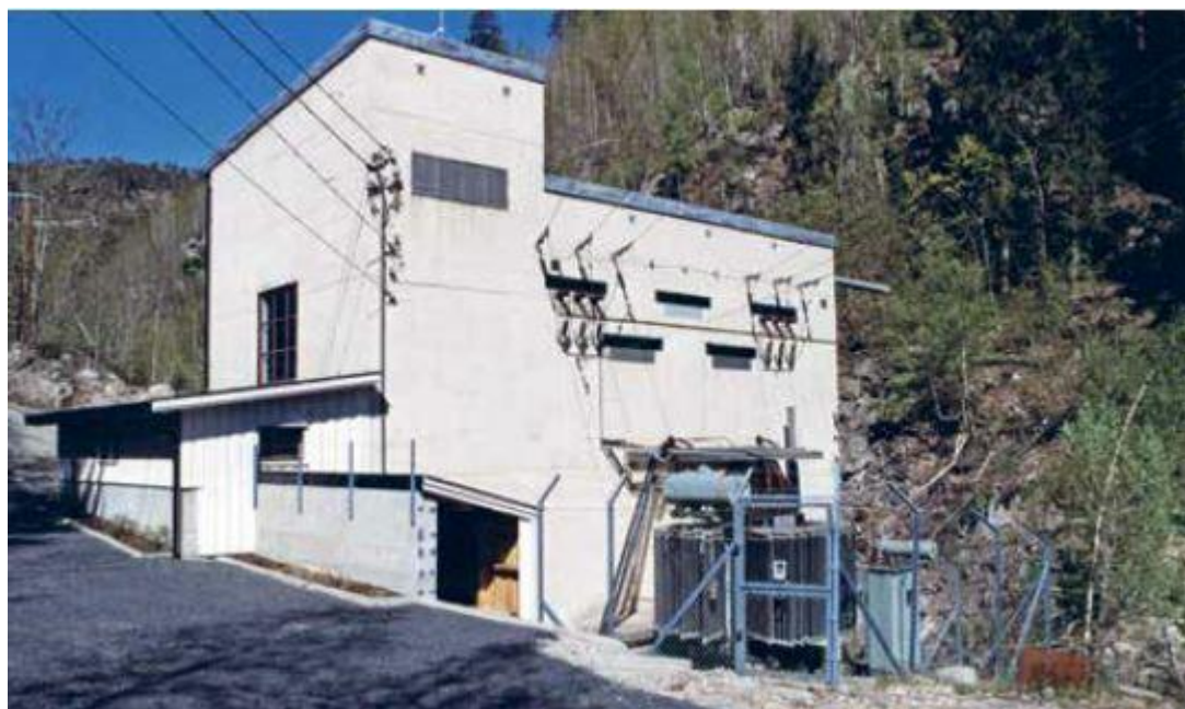
Figur 18: Det gamle, nå nedlagte Suvdøla kraftverket, sett mot nordvest. Kilde: https://www.drangedalkraft.no/kraftverk
