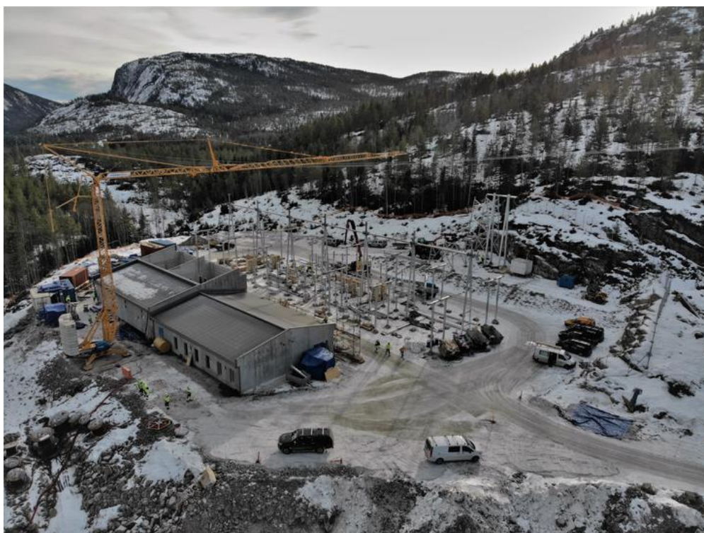
Figur 16: Bilde fra konstruksjonen av transformatorstasjonen fra 2020, sett omtrent mot sørøst.
