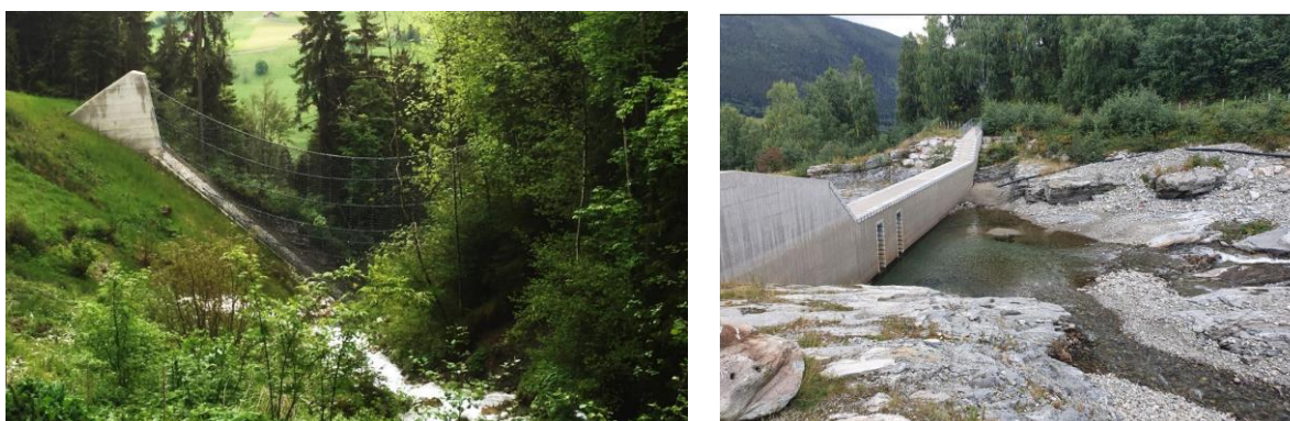
Figur 5-24 Eksempel på nett og bunnlastsperrer.
