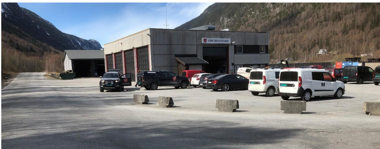
Figur 4-9 Problemområde 3. Portene til brannstasjonen går rett ut mot Svaddevegen.
