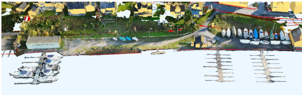
Figur 5-5. Dronesanning av parsell 1.
