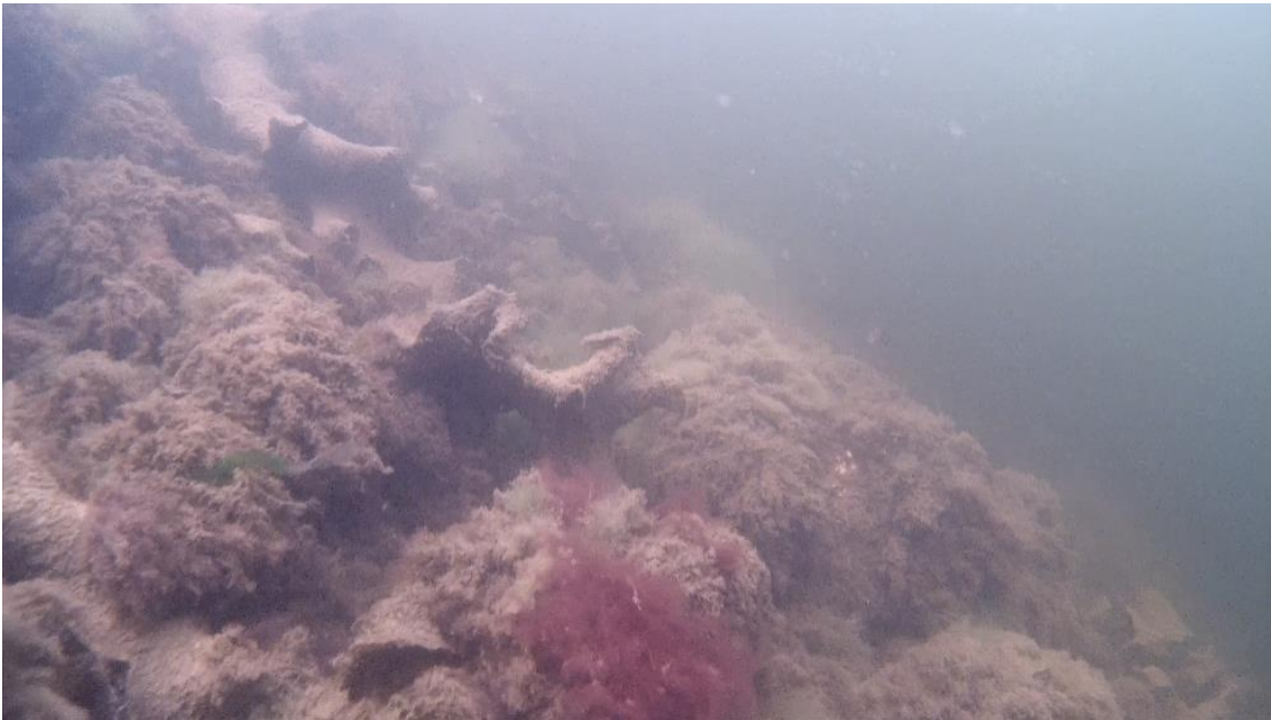
Figur 6.16: Bilde tatt med ROV langs strandsonen ved vanddyb 2 m som viser steinfyllingen med påvekst av makroalger. Bildet illustrerer hvordan området er svært preget av nedslamming/lurv. Foto: Kine Øren/Sweco
