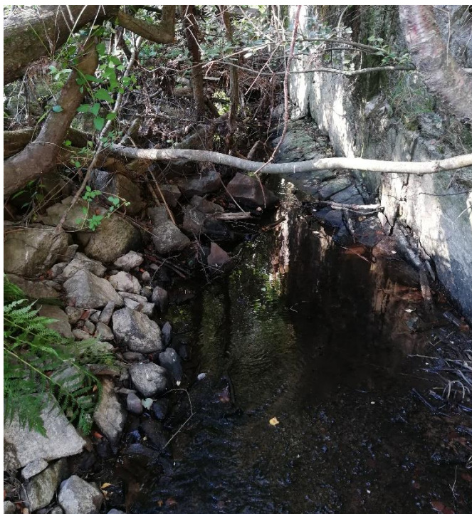
Figur 4. Oversiktsbilde fra stasjonen i Rutua
