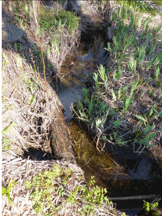
Bilde 5. Noe overhengende elvebanker i Kjøyabekken
