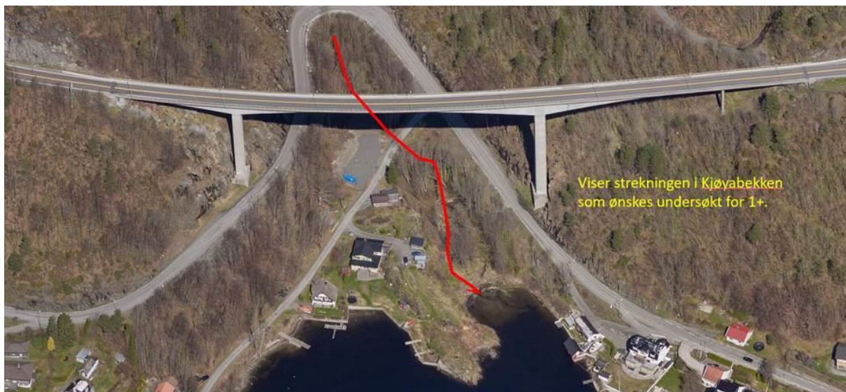
Bilde 1. Undersøkt strekning i Kjøyabekken.
