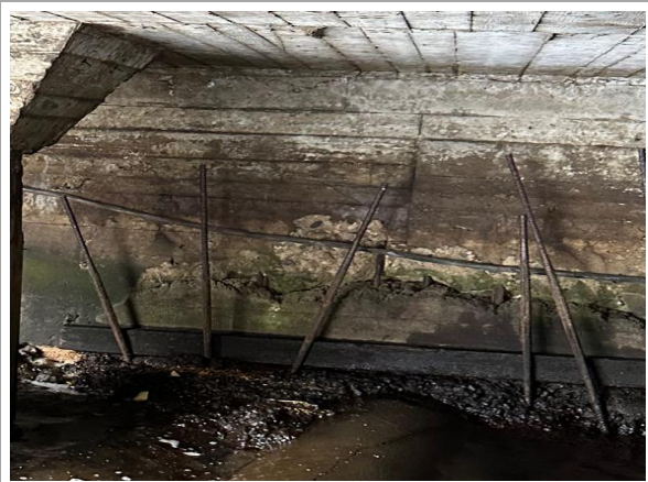
Bilde 21: Kabelledning under kaidekket.
