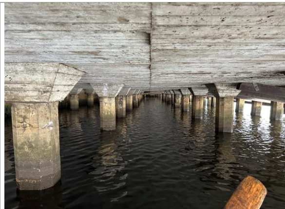
Bilde 17: Bilde av prøvetatte betongpilarer (polygonformet) under kaidekke, prøve nr. 8.
