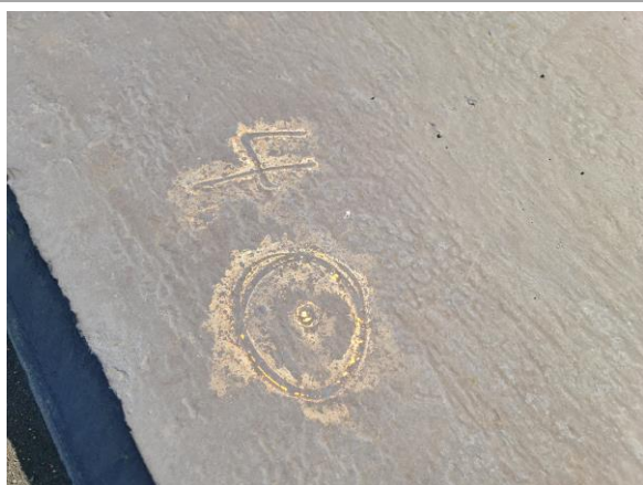
Bilde 7: Betongdekket ved prøvepunkt BORR 04-01.
