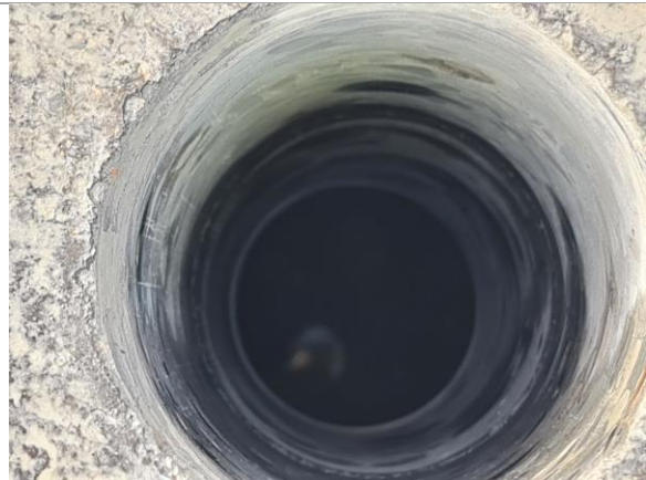
Bilde 11: Oversiktsbilde av betong fra topp- og bunndekke.
