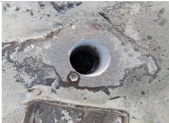
Bilde 14: Betongprøvepunkt ved prøvepunkt BORR 10-01.
