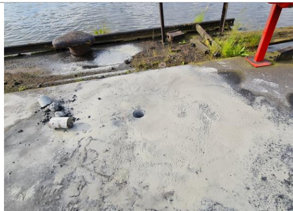
Bilde 13: Betongprøve ved prøvepunkt BORR 08-01/02.
