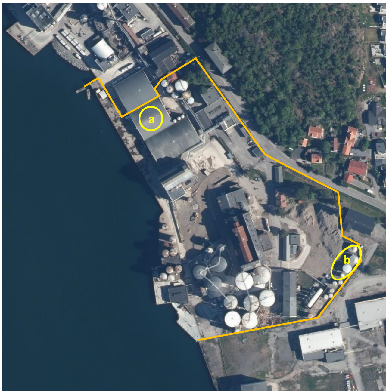
Figur 2 Satellittbilde av Framnesveien 57 hentet fra Sandefjord Kommune Kart. JNP er omrisset i oransje; lagerhall for IBC-containerer og tankgård er sirklet i gult, og markert med henholdsvis "a" og "b"
