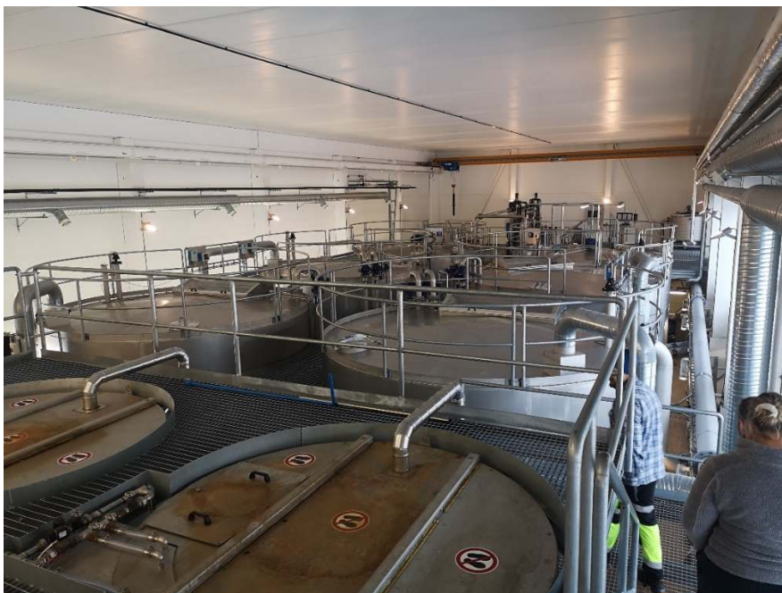
Figur 4-1: Hartevatn renseanlegg i Hovden som er et industrihallbygg.
