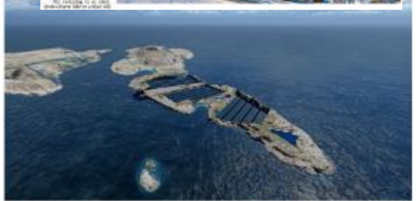
Sikringsarbeidet må avklares. Det er den store utfordringen for kommunen, som har fått i oppdrag å sikre området. Foto: Lars Bryne
