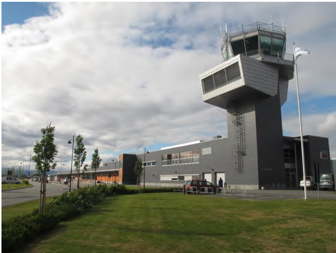
Figur 1. Terminalbygget Alta lufthavn. Foto: Rune Solvang.
