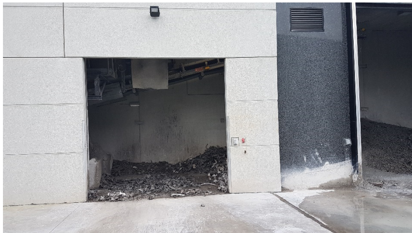
Bilde 2: Magnetutskiller, åpning i fasade mot sør
