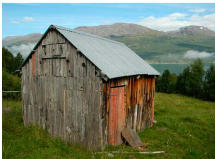
Høyskjå i stavkonstruksjon, delvis med råved i bjørk i konstruksjonen. Ytre kledning av låvepanel og til dels kassebord. FOTO: RANDI SJØLIE
