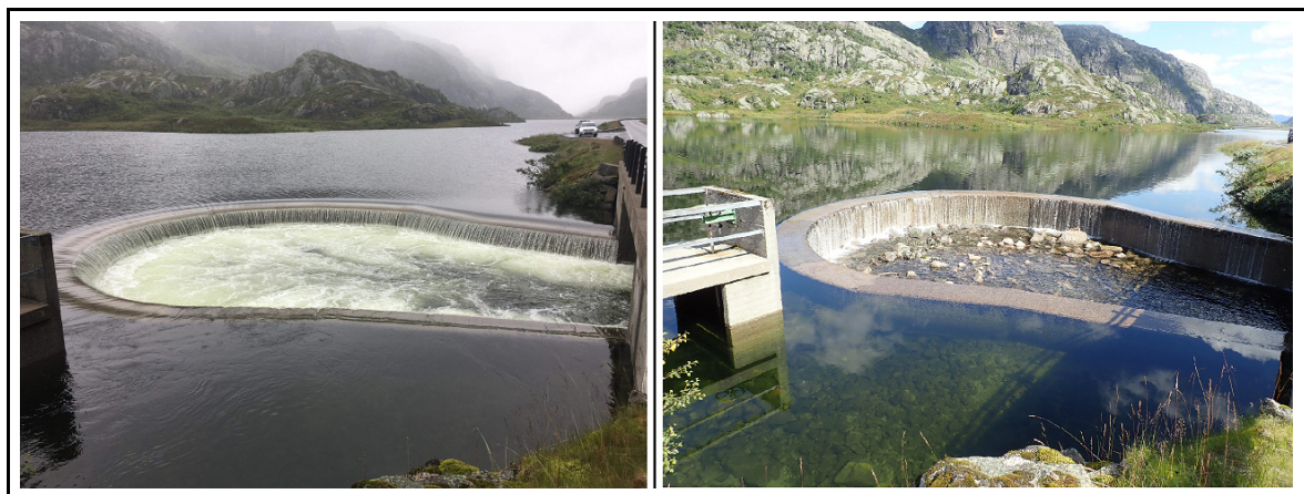
Dammen i utløpet av Hunnevatn i ulike situasjoner med overløp (venstre foto: Mats Grendal). Til venstre skimtes anordningen for manuell slipning av minstevannføring. Denne er seinere automatisert.
