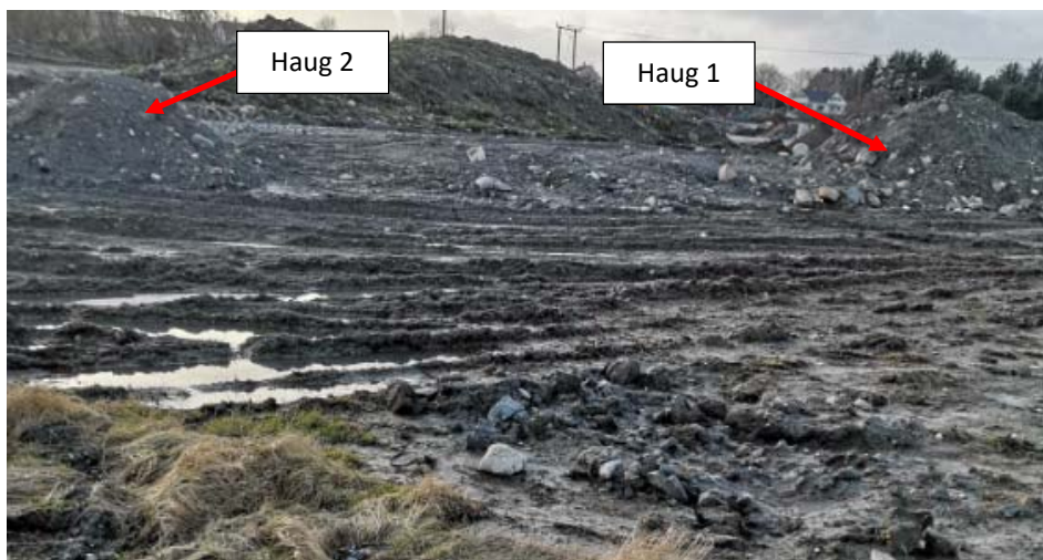
Figur 3 Foto fra befaring viser to hauger med avfallsfraksjoner (overskuddsmasser fra kabelgrøft) og at toppdekket er fjernet. Bildet er tatt fra sjøkanten og mot sørvest (foto: Lunestad, 6. februar 2019).
