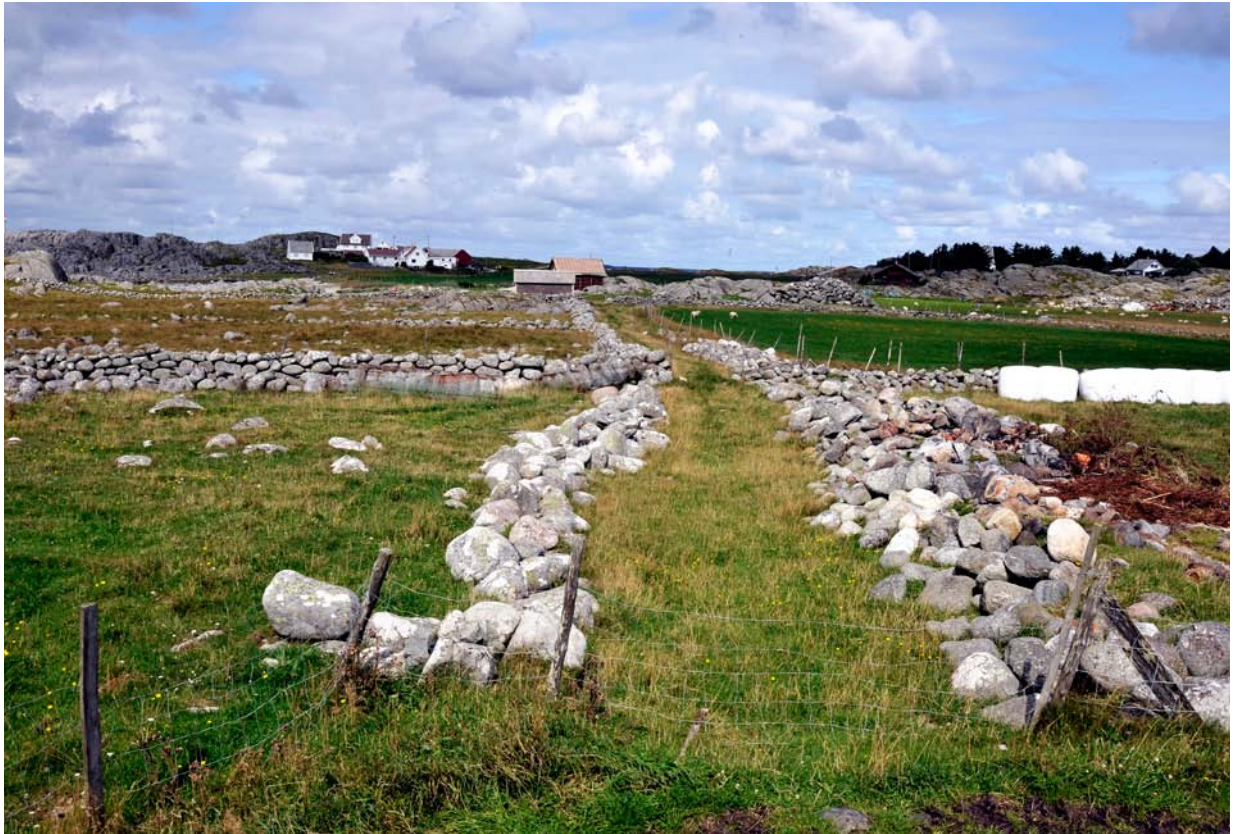
FIGUR 132. Steingardar og geil på Nes, ved Litlatre. Tunet på bruk 23/2 i bakgrunnen.
