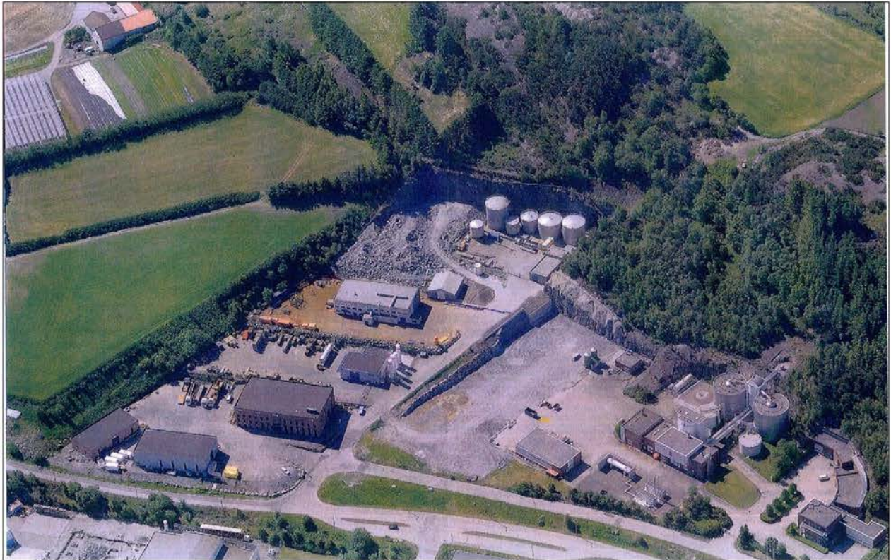
Figur 4.2. Tiltakstomt under utvikling øverst i bildet og naboer sørvest for Mekjarvikveien. IVAR ses i høyre del av bildet. Øverst til høyre i bildet ligger Stavanger Slop som grenser til Henriksens tomt. Nedenfor følger Procoat AS, Dominion Gass (med de fire store gasstankene) og Varaberg Eiendom.
