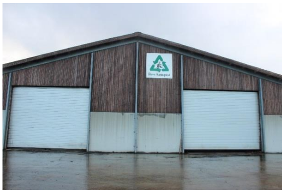
Figur 4: Endevegg med to porter for uttak av ferdig kompost/ levende jord.
