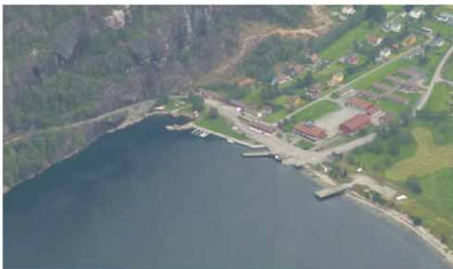
Figur 4-9 Lysebotn med dagens molo og småbåthavn til venstre. Midlertidig anleggsveg er under bygging. Foto: Astrid Norland
