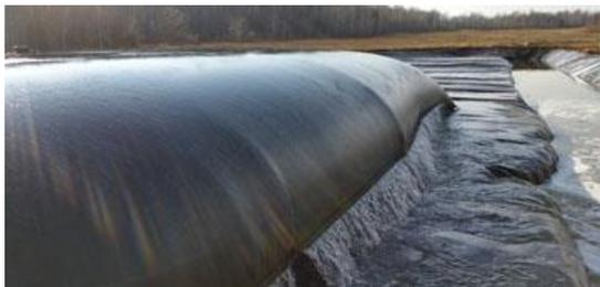
Det planlegges å bruke geotuber om bord på lekter ved mudringstedet. Geotuber er en energigivning avvanning med gode resultat.
