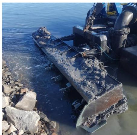
Sugemudring er en metode som generelt gir lite spredning av sedimenter under arbeidet, men som gir store vannmengder i oppmudret masse. Å få avvannet massene effektivt er som oftest et problem. I Gilhusbukta sugemudres det forurensede finkornede sedimenter som blir pumpet til geotuber på land. I pumpeledningen tilsettes det polymerer for at avvanningen i geotubene skal bli mer effektiv.
