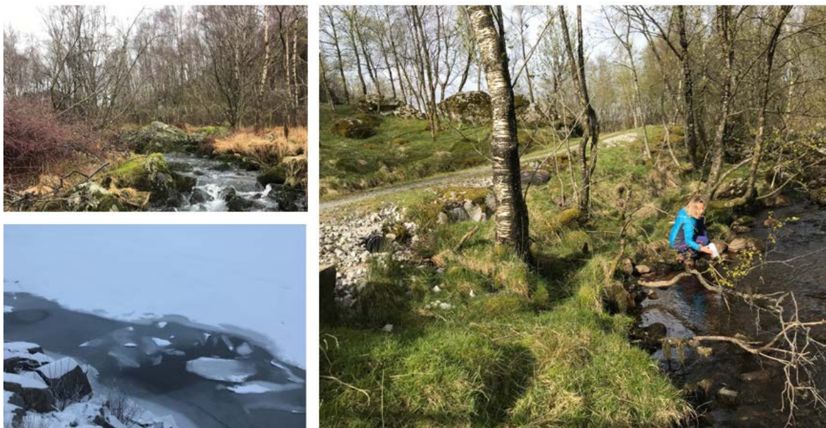
Figur 6-2: Bekk fra Kyrjtjørna med utløp til Ytra Kydlandsvatnet (bildet nederst til venstre) gjennom fylling under dagens E39. Traktorveien er regulert inn som anleggsvei og må sannsynligvis oppgraderes.
