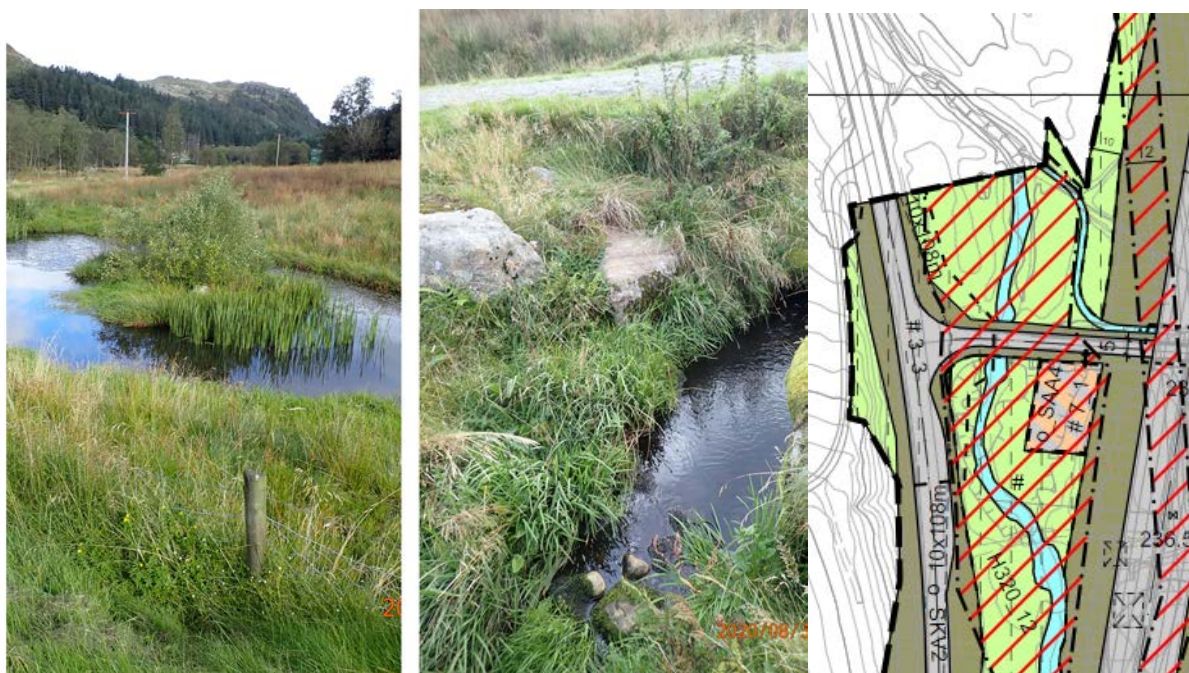
Figur 6-7: Sedimentasjonsbasseng med utløpsbekk ved Nedrebøvegen. Utsnitt fra plankartet viser at bekk og Nedrebøvegen skal gå i kulvert under ny E39.
