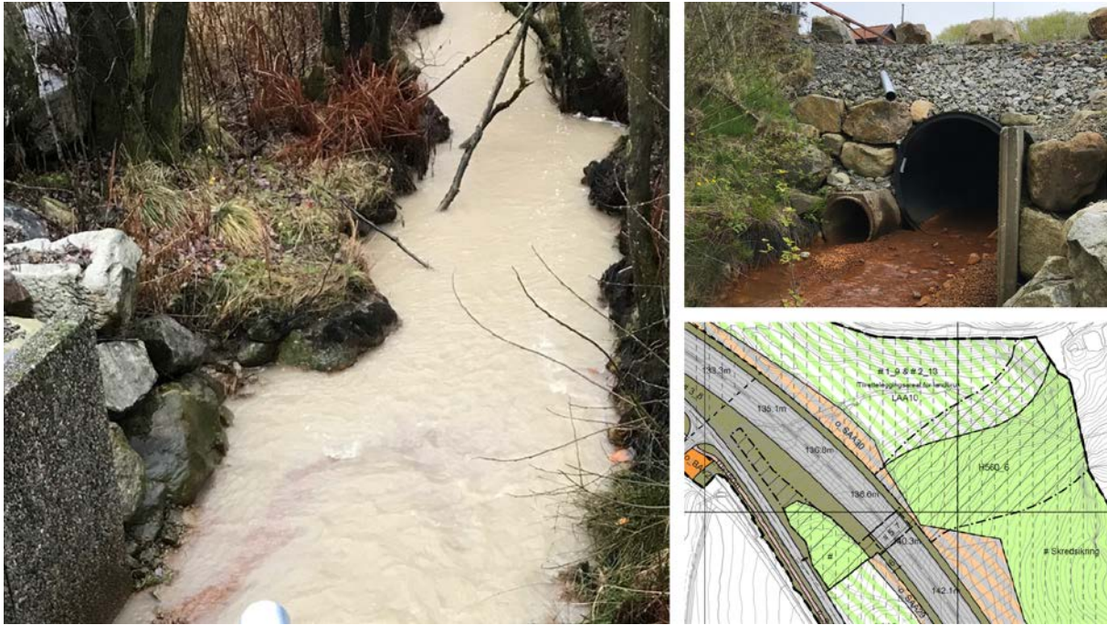
Figur 6-20: Kleivabekken går i rør under dagens E39. Utsnitt fra plankartet viser ny kulvert som skal etableres her. Bekken skal legges om i åpent løp innen hensynssone H560_6.
