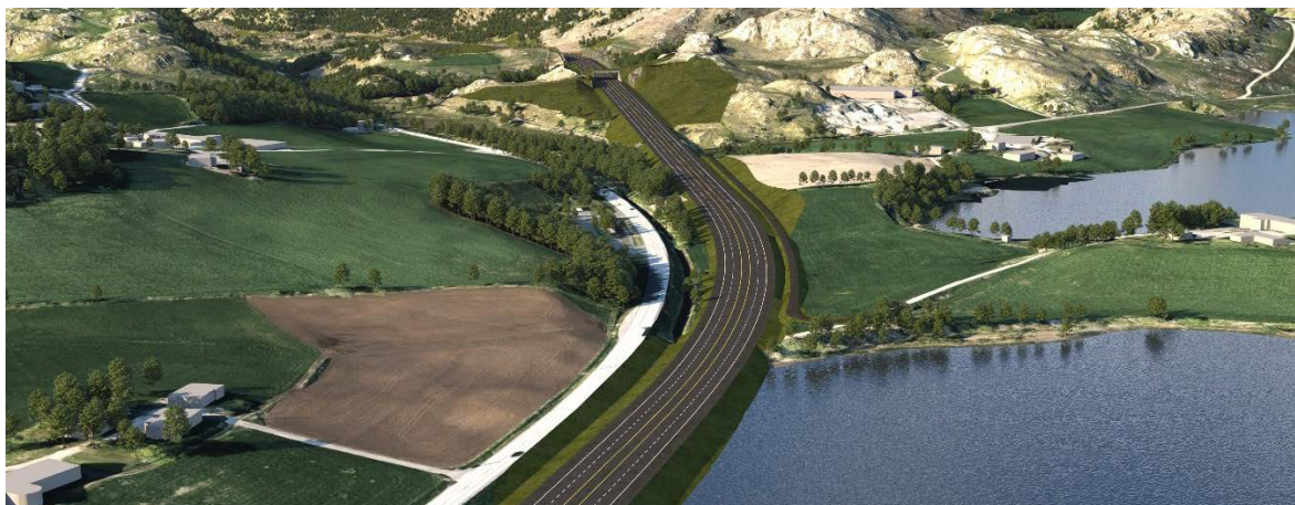
Figur 6-6: Ny E39 fra Søylandskiosken i enden av Ytra Kydlandsvatnet og nordover mot Gautedal. Kanal/utløp Ytra Kydlandsvatnet ligger mellom gammel og ny E39.
