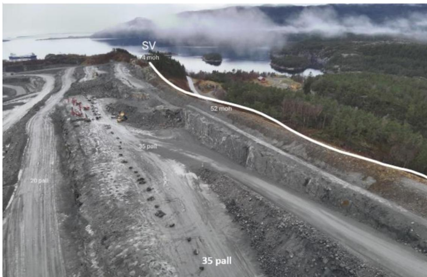
Bilde 3: Plassering av piggmaskiner og annet utstyr på 35-pallen, med skjermingsvoll synlig på 52 moh. Foto innsendt av Mibau Stema den 19.12.2025, ifm. tilbakemelding på vårt varselbrev.
