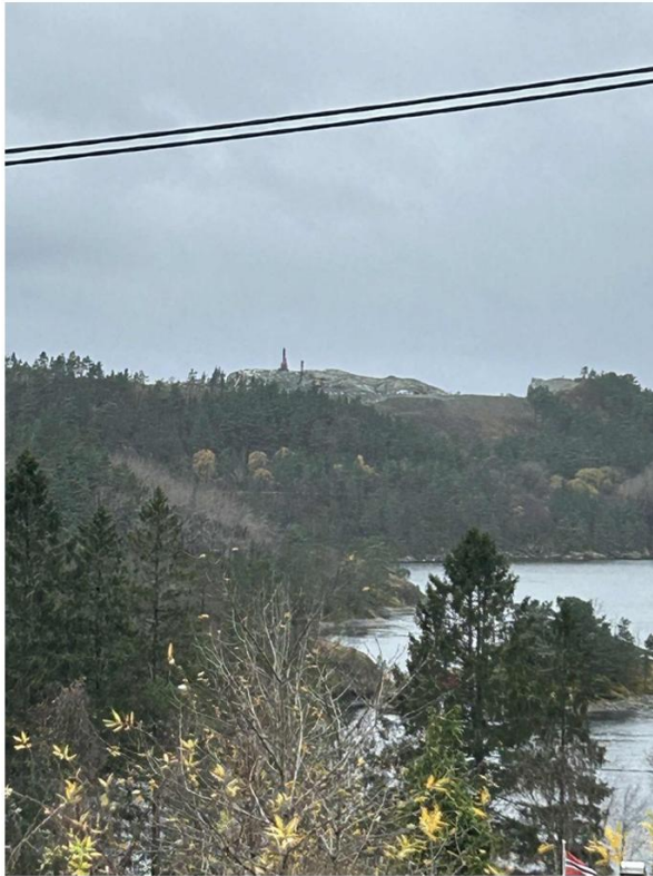
Bilde 1: Pigge/gravemaskin plassert uskjermet på toppen av bruddet mot nord. Foto vedlagt klage på støy mottatt fra Skreddarnesvegen 04.11.2025 (Ref. sak 2017/9400-361).
