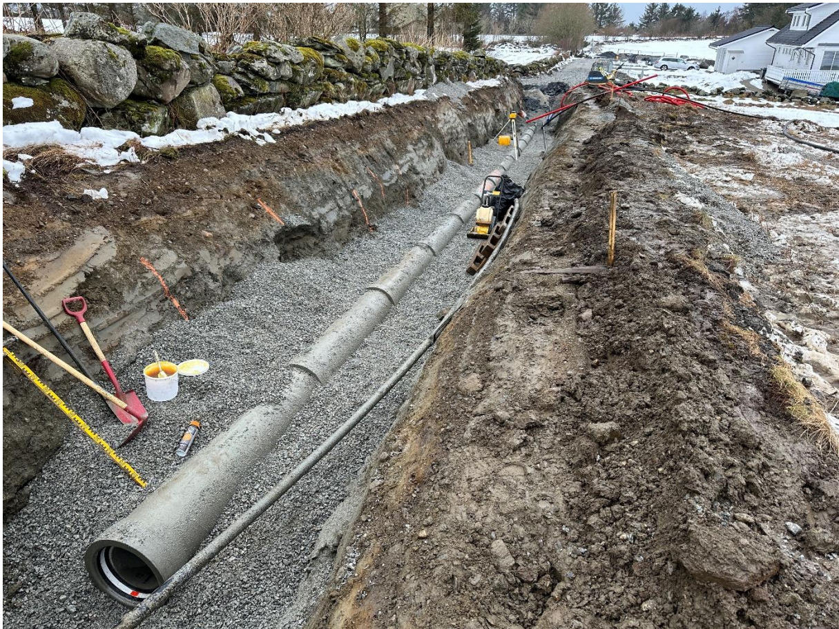
Figur 8. Ny kommunal spillvannsledning i Øygardsveien. Bildet tatt av Kristin Herdis Bringedal
