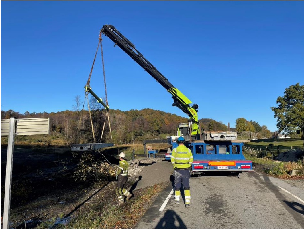
Foto: Haugaland vannområde. Etablering og montering av hulldekker. Broløsning for traktor over bekken.
