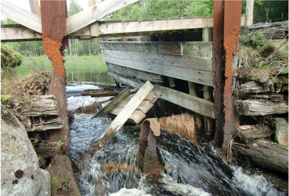
Demningen i Hallerødelva før restaurering. Foto: Håvard Hornnæs
