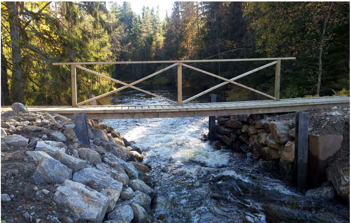
Demningen etter restaurering i 2015. Foto: Leif R. Karlsen
