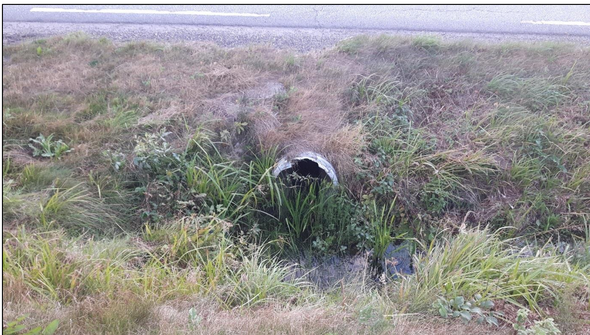
Bilde 11. Liten kulp før bekken igjen går under fylkesvegen. Kulpen bør graves ut og tilføres en del stein.
