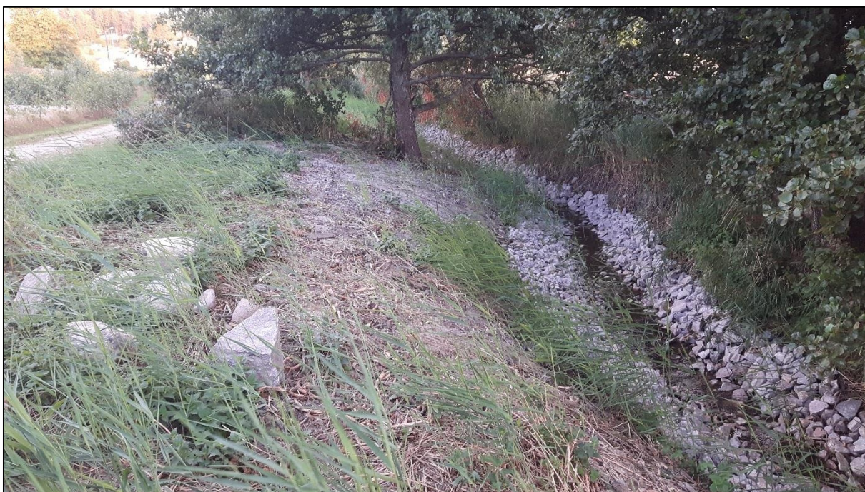
Bilde 4. Rensing og steinsetting foretatt juni/juli 2018. Steinene til venstre i bildet skal senere legges ut i bekken for å danne små kulper/terskler.
