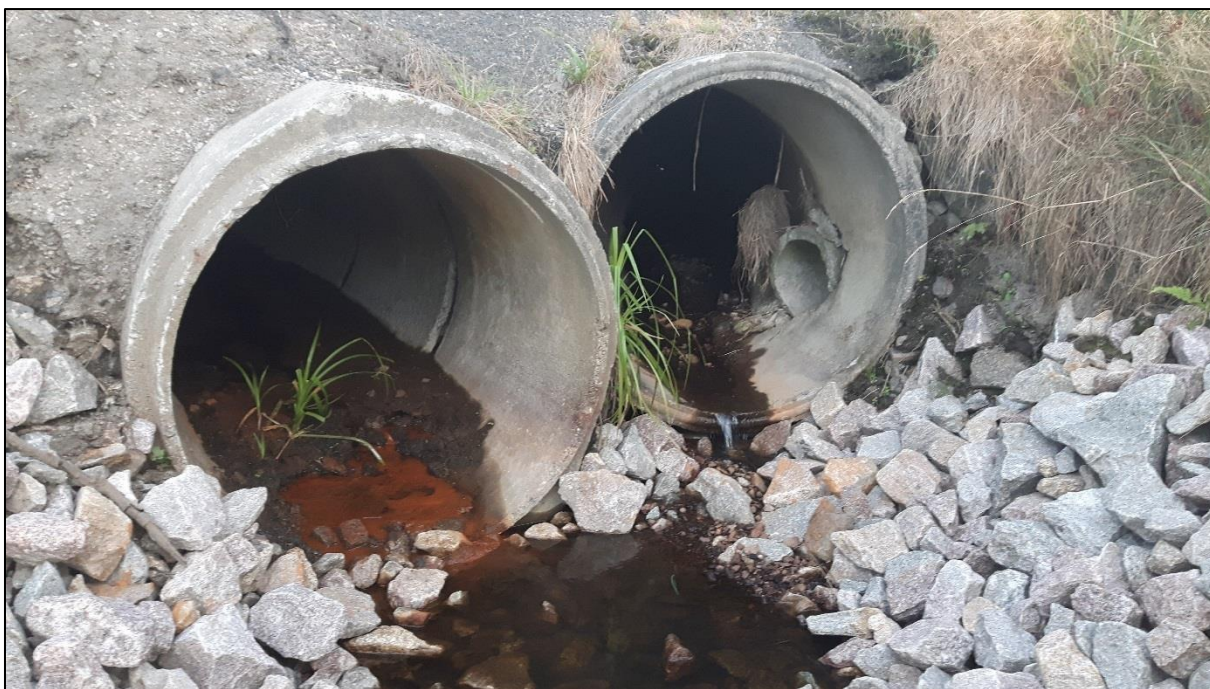
Bilde 7. Kulvertene under Fv. 116. Kulverten til høyre fører vann fra løpet som kommer fra vanningsdammen. Den til venstre fører vann fra det nord-østre løpet og er nærmest gjengrodd.
