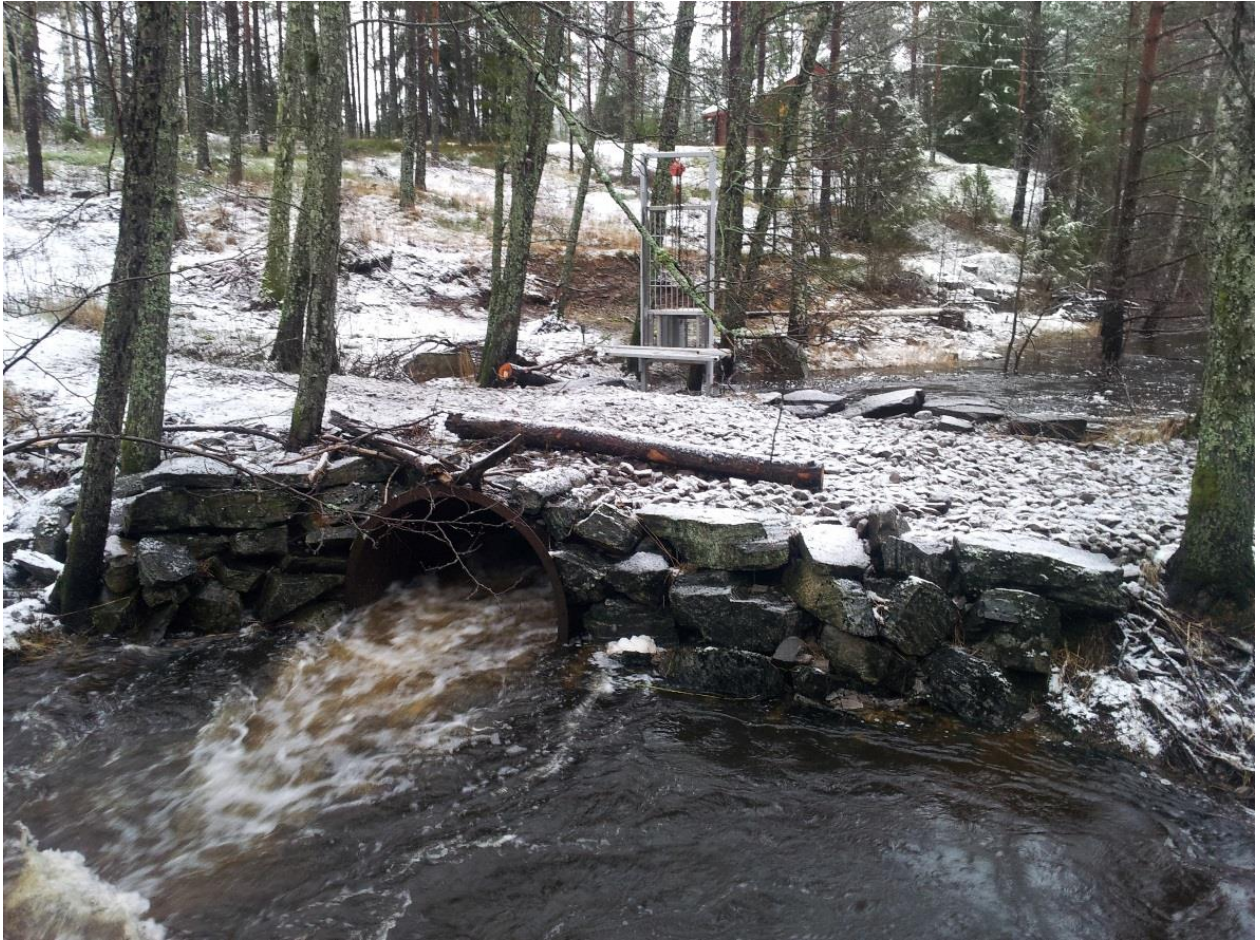
Fig 5. Kulvert/rør og Myhre-teller øverst i sideløpet den 11.12.2014. (25 m 3 /sek. i Enningdalselva)
