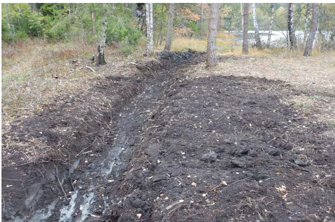
Fig. 9. Grøfta ved utløpet i sjøen ble grunnere enn planlagt da det her er grunnlendt over et større område. Foto: Ola Wergeland Krog.
