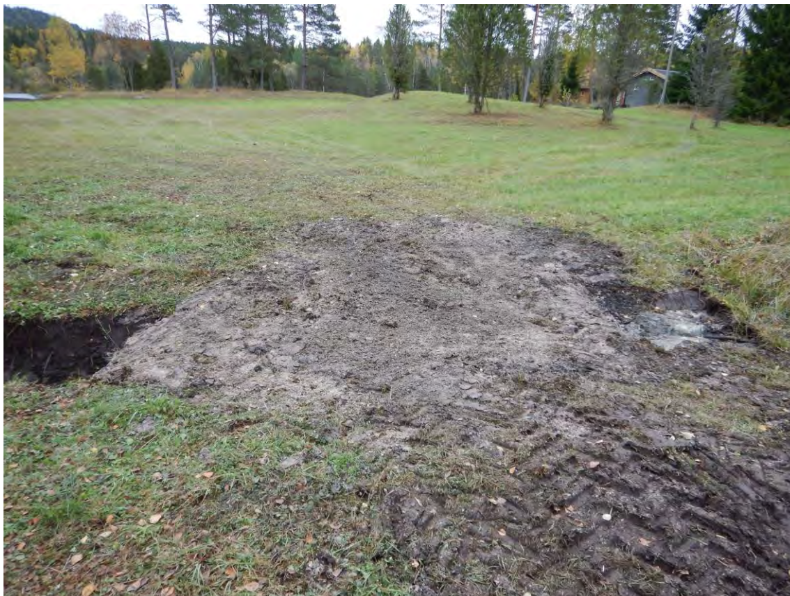
Fig. 5. For å kunne krysse over grøfta ble det lagt ned et 150 mm plastrør som ble overfylt med grus og et topplag med stedeagne masser. Foto: Ola Wergeland Krog.
