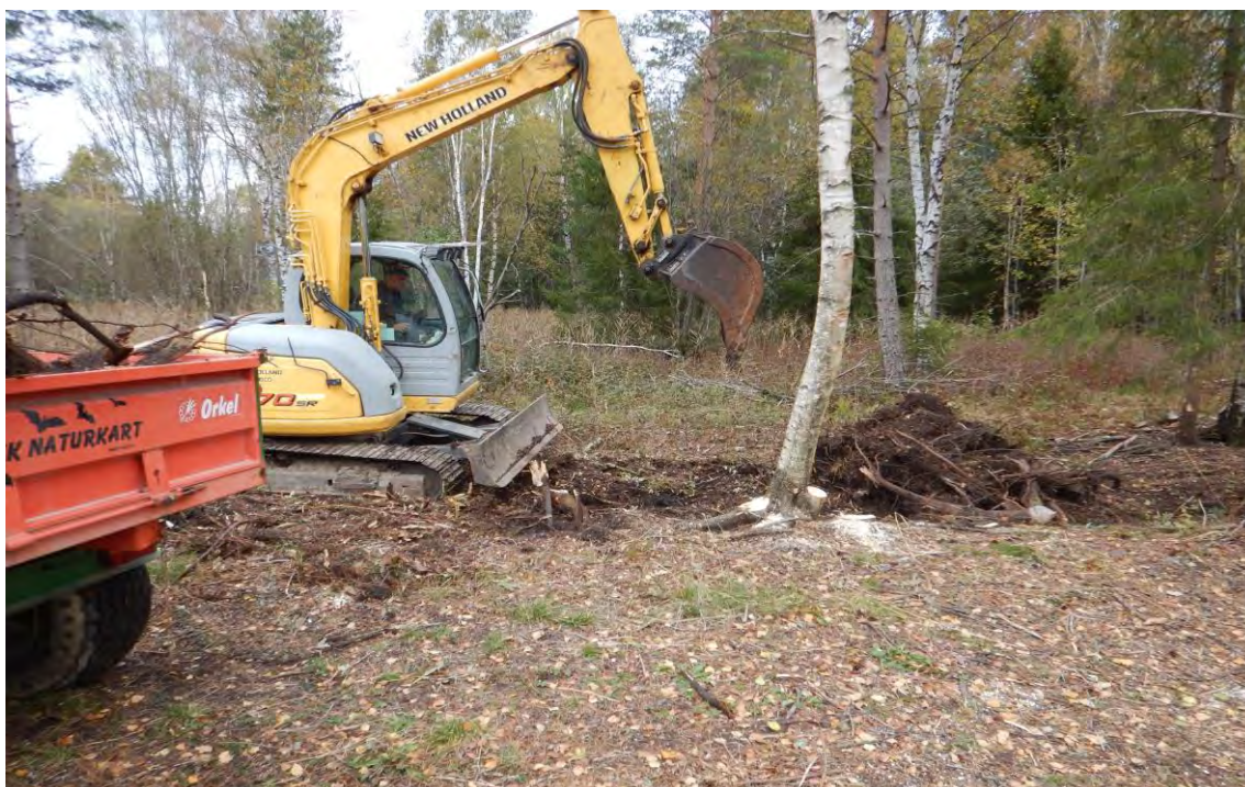
Fig. 14 For å minimalisere skadene på enga ble jobben gjort med en lett traktor med boggihenger og en 7 tonns beltegraver med brede belter.
