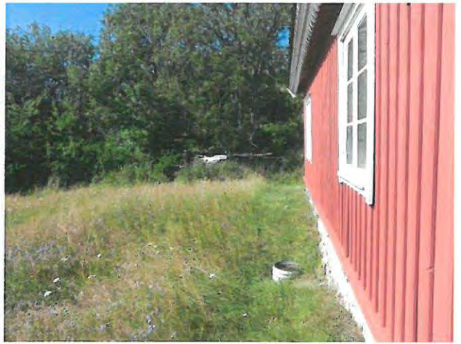
Figur 11. For få år siden ble det lagt en drenering i rør fra husveggen og rett sørover. Foto mot vest, 1.8. 2015. (UTM32: 619266, 6542426).
