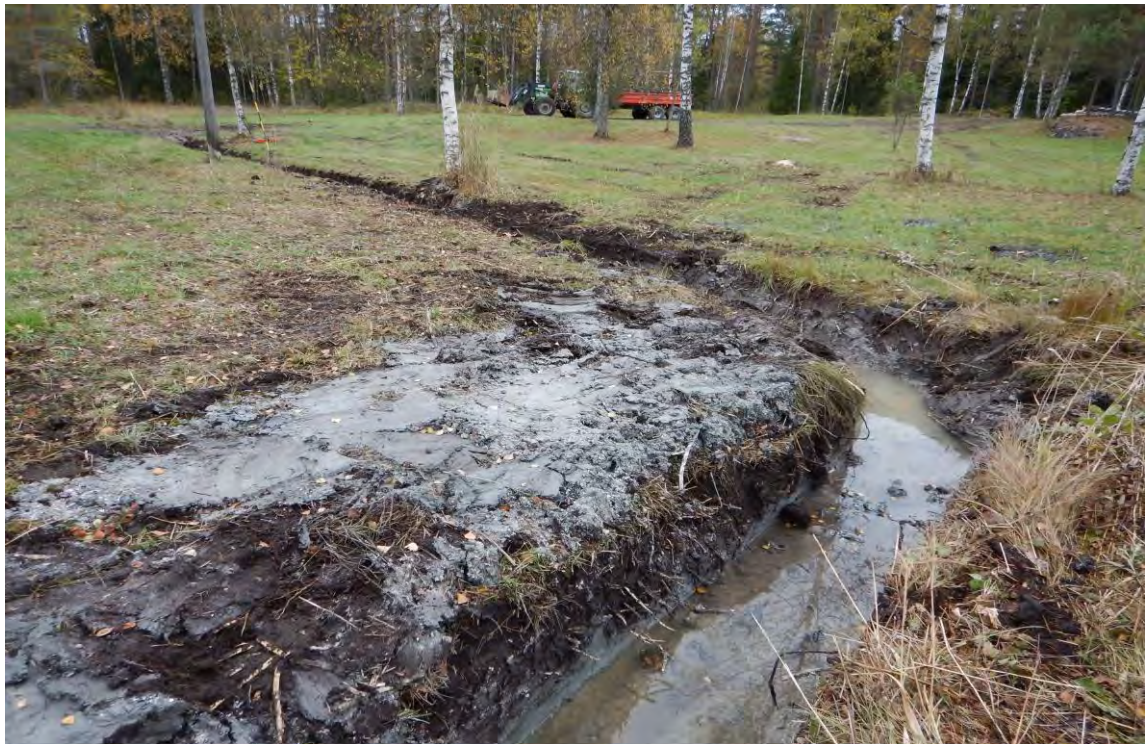
Fig. 11. Siste del av grøfta fra svingen og opp til krysningspunktet øverst til venstre i bildet. Foto: Ola Wergeland Krog.
