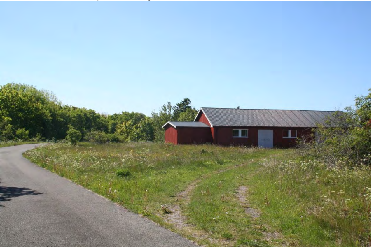
Bilde 4 Lokaliteten Verkstedet. Bildet er tatt sørover. På engene rundt dette bygget var det stor flygeaktivitet av prikkroutevinge.
