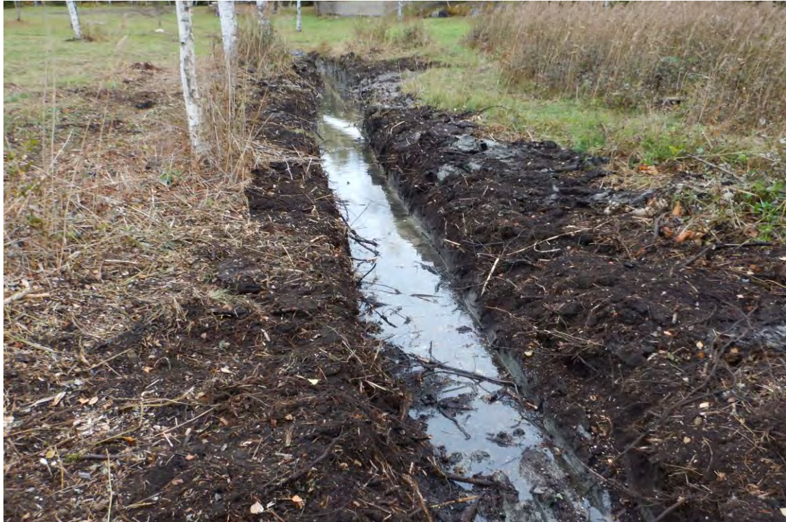
Fig. 10. Grøfta mellom utløpsgrøfta i figur 9 og vinkelen der den svinger sørover. Grøfta ble her gjort ekstra dyp for å kutte utløperne fra takrørskogen nord for grøfta (til høyre i bildet). Foto: Ola Wergeland Krog.
