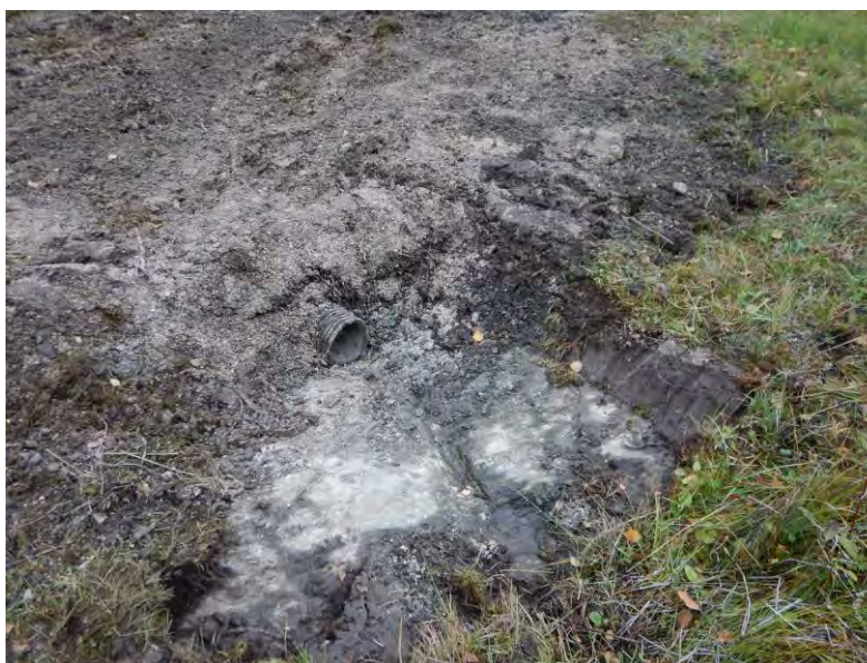
Fig. 6. For å unngå at innløpet til drenerørret skulle gro igjen ble berget skrapet rent for løsmasser. Foto: Ola Wergeland Krog.
