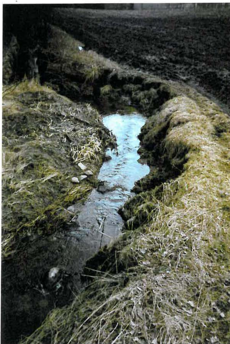
Figur 2. Smal bekkkant med utrasing. Her er det aktuelt med pøling, utretting eller andre sikringstiltak.
