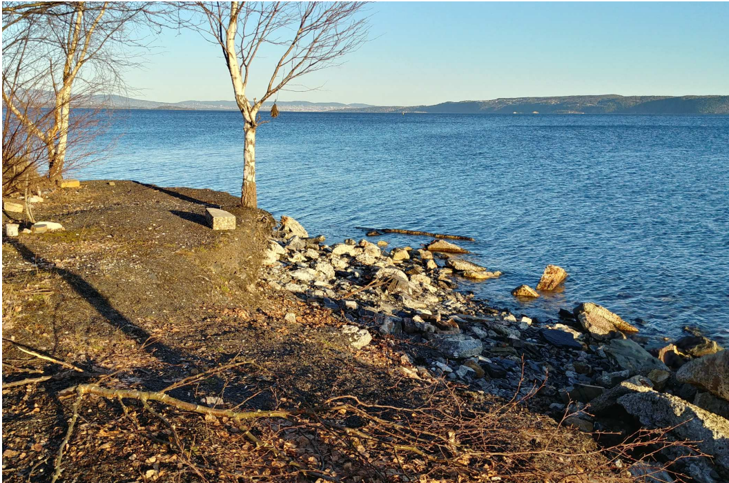
Figur 5: Bildet viser at det foregår bølgeerosjon langs kystlinjen til fyllingen.
