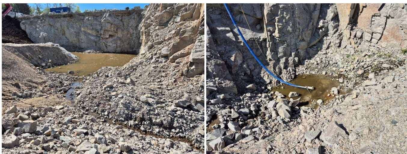
Opsamling av vann og utpumping av vann.
