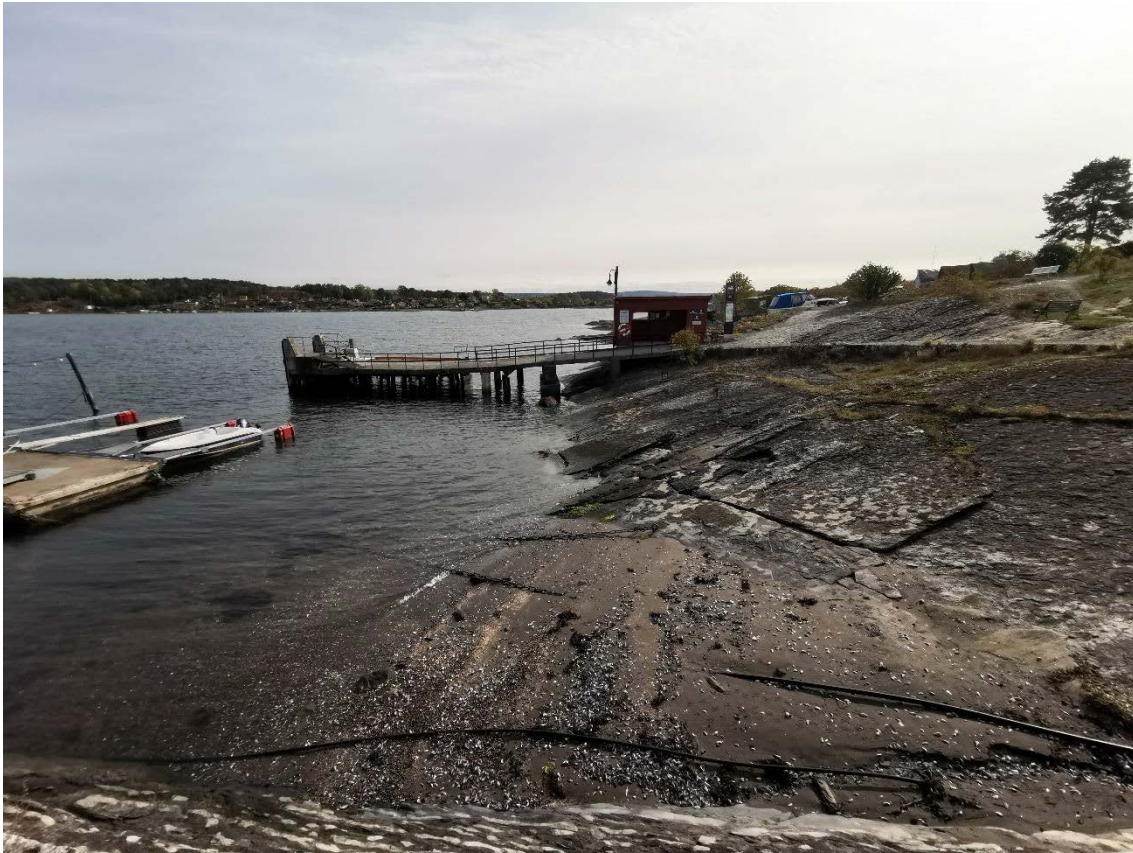
Figur 5-5. Nakkholmen brygge med strand dekket av tomme skjell.
