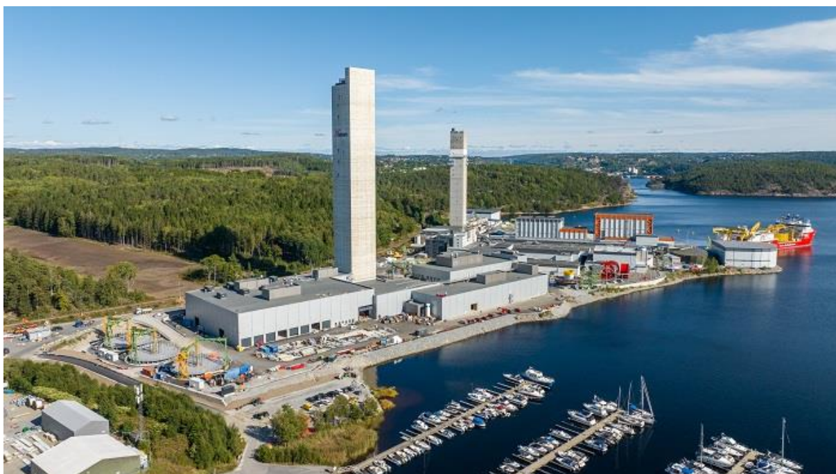
Figur 1. Bilde av dagens fabrikk og den nye fabrikk under ferdigstilling.
