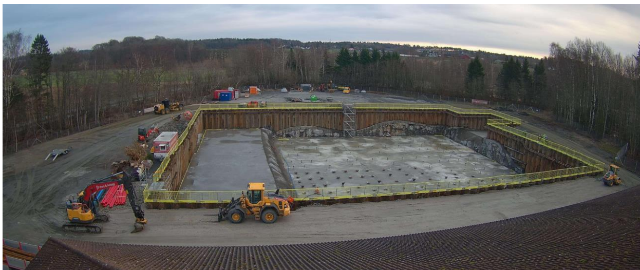
Figur 1. Bilde fra byggekamera på Fuglevik den 24.11.2025. Nytt BIO-bygg.
