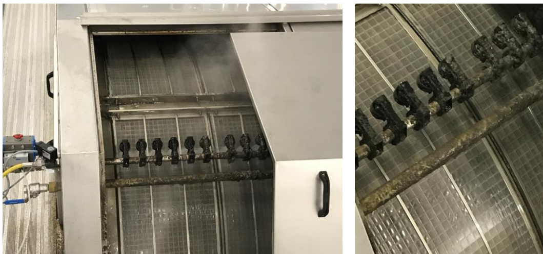
Figur 11. Hydrotech trommelfiltre installert på SNJ i Stavanger.
