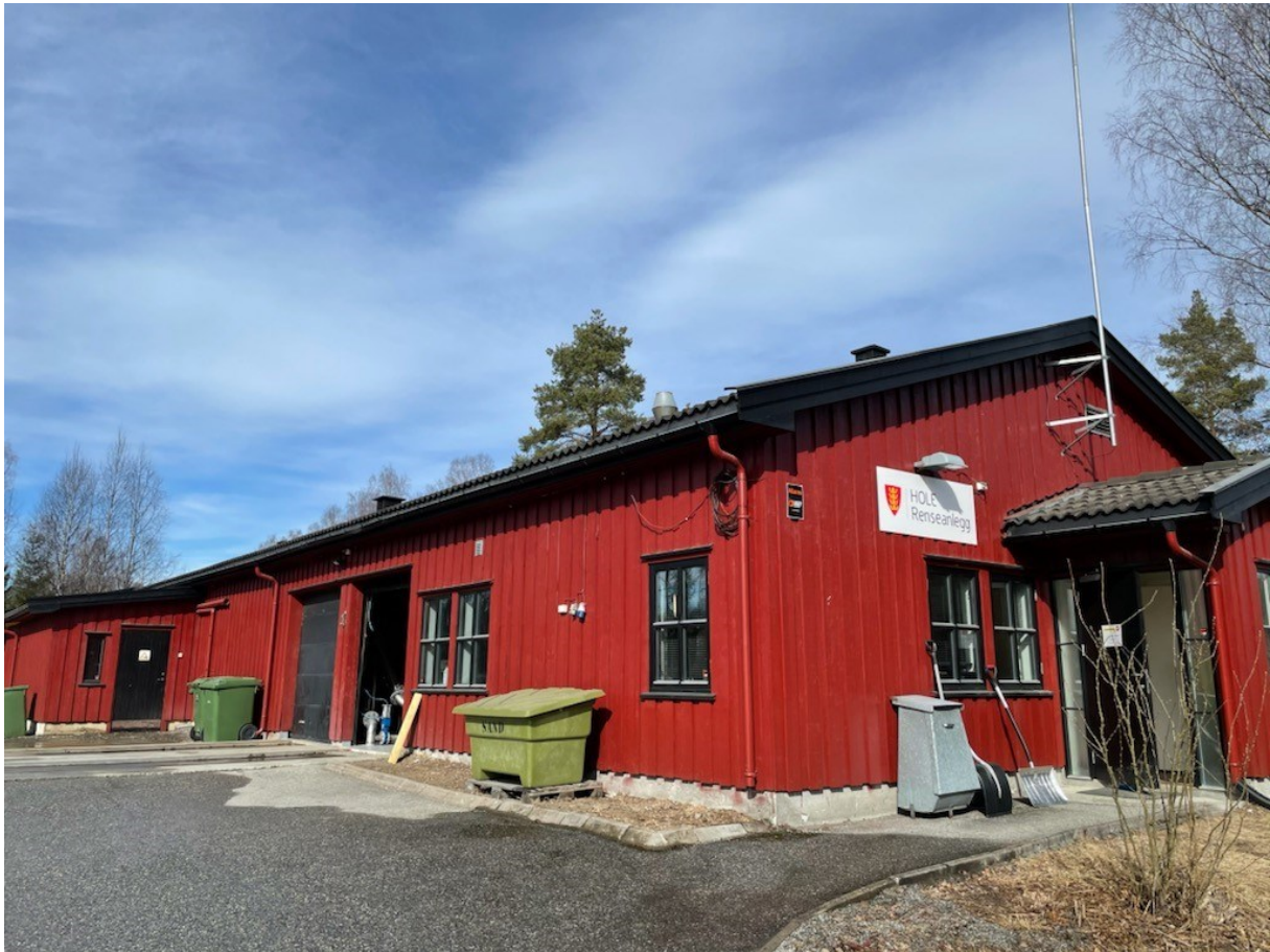
Bilde 1 Hole renseanlegg
