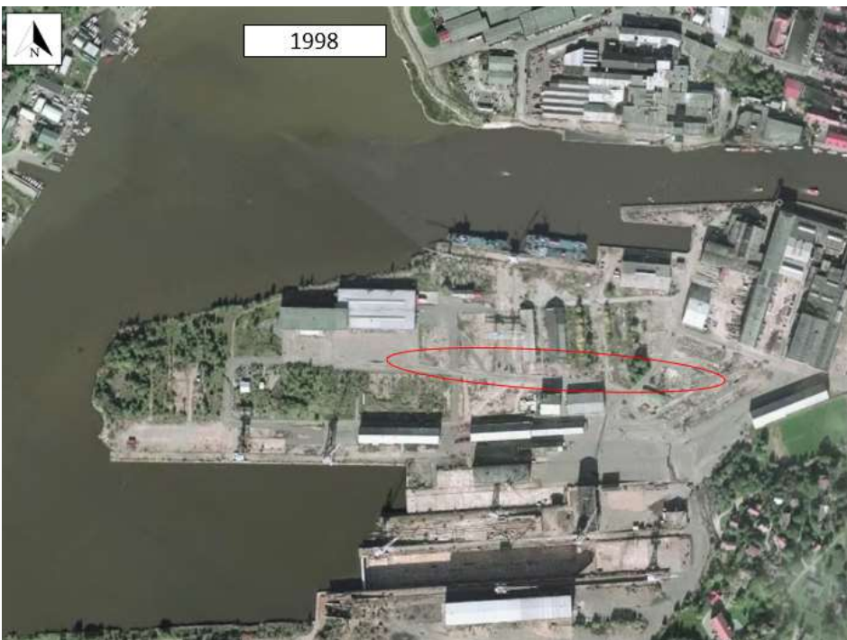
Figur 9: Historiske flyfoto fra år 1998. Tiltaksområdet er markert med rød ramme. Kilde: Norgebilder.
