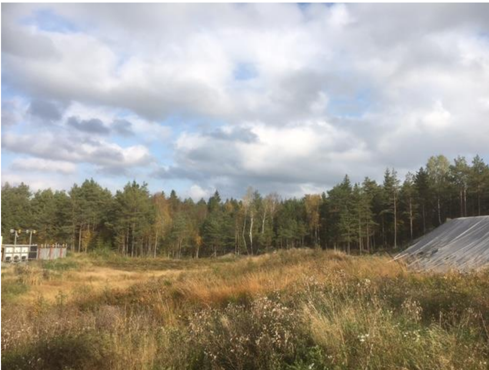
Figur 8. Det foreligger fuktige partier mellom skivevoll og kulefangervollen på 100 meters banen, Fjell skytebane, Våler kommune, september 2017.
