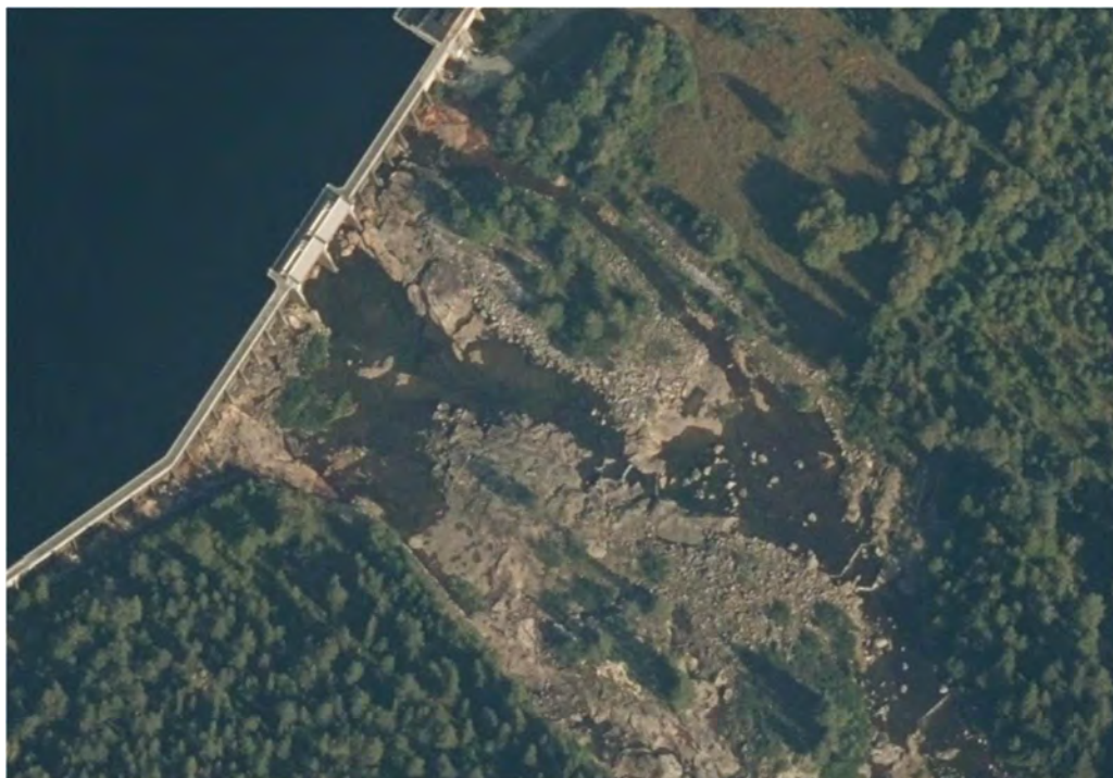
Figur 13: Flyfoto av Dam Eikrebecken og området nedstrøms.
