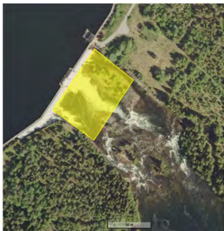
Figur 27: Flyfoto fra dam Eikrebekken. Gult areal indikerer omtrentleg område der graving i elvestreng er aktuelt.
