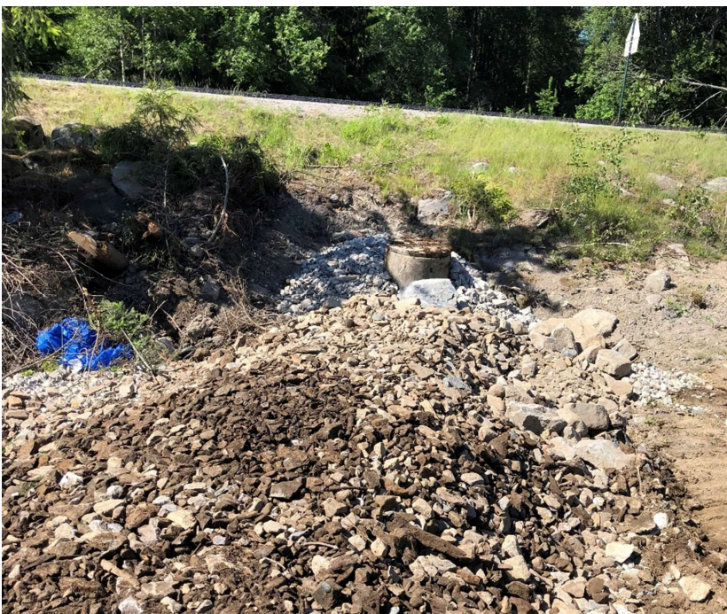
Figur 11 Etablert steingrøft. Dagens terreng på fylling er atskillig meter høyere enn Hobølveien, som her ses i bakgrunnen.
