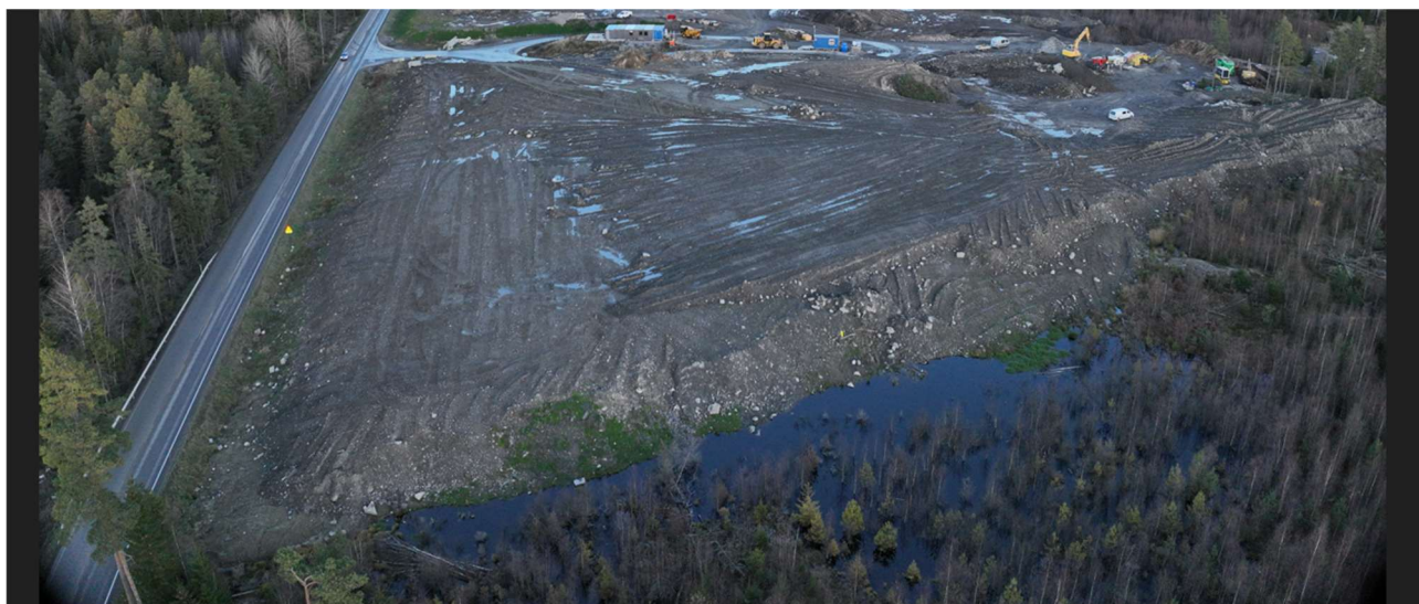
Figur 7 Dronefoto sett mot nordøst. Området i vest, nedenfor eksisterende fylling, står under vann.
