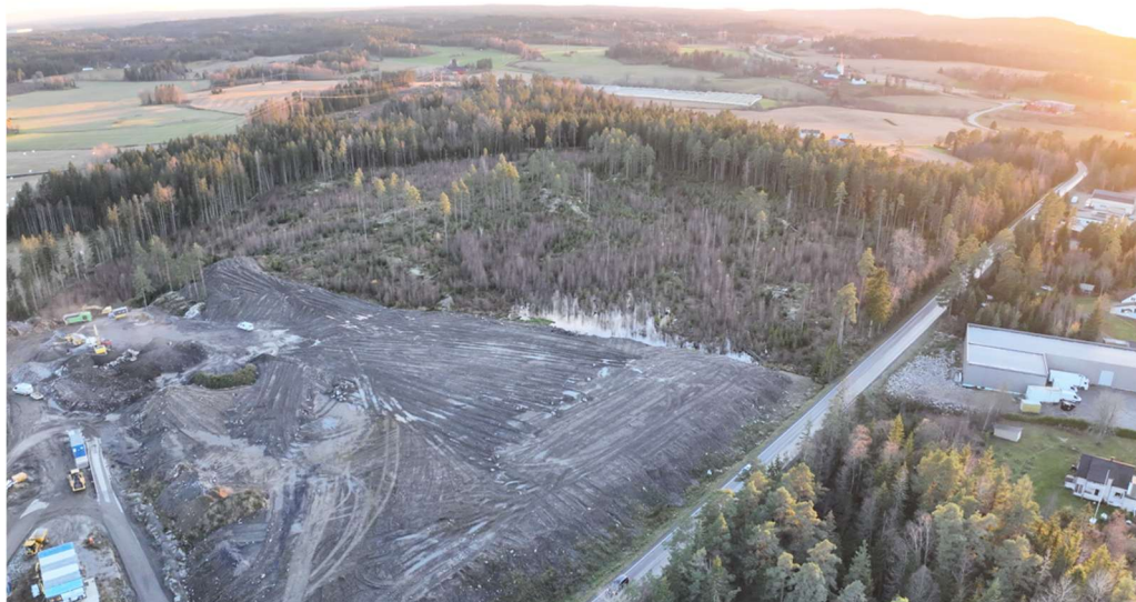
Figur 12 Dronefoto, mot sør. Skogsareal sør av dagens fylling/mottak planlegges for utvidet massemtak
