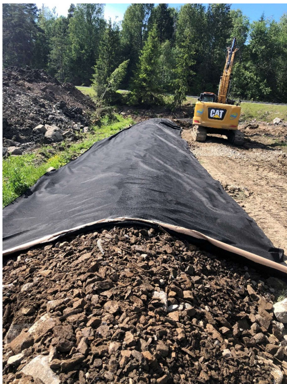
Figur 8 Etablert steingrøft. Dekket med duk. Dagens terreng på fylling er atskillig meter høyere enn Hobølveien, som her ses i bakgrunn.
