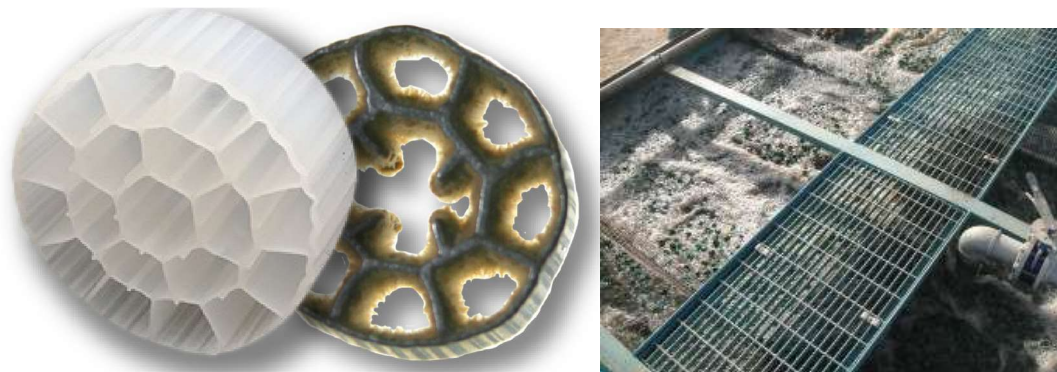
Figur 10: Illustrasjon av bæremedie tilsvarende K5 med og uten biofilmvekst, samt en luftet reaktor uten overdekning. (Kilde: dynamixinc.com og iwater.com)
