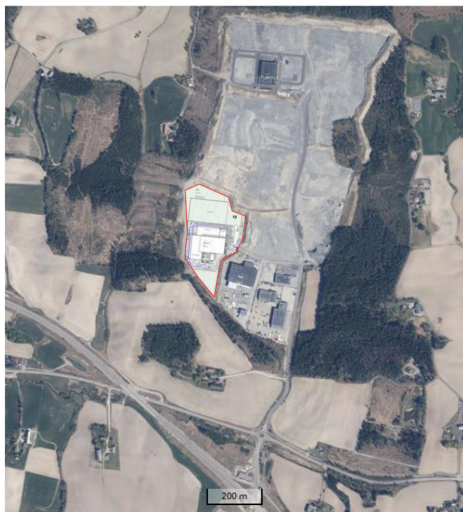
Figur 2: Utsnitt over Holtskogen næringspark med visualisering av E18 og anleggets plassering i næringsparken.
