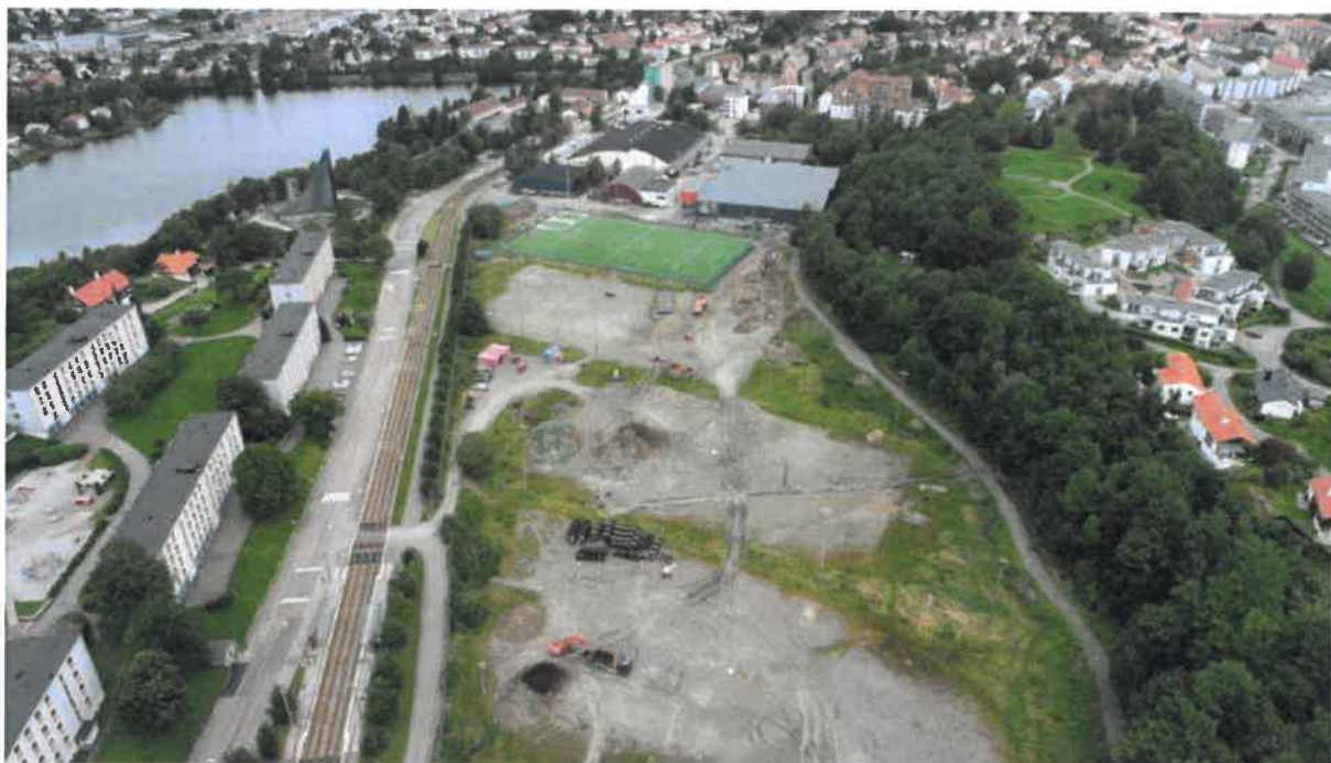
Figur 1 Slettebakken avfallsdeponi har inntil nylig blitt benyttet til grusede fotballbaner. Bilde tatt september 2020 av Bergen kommune
