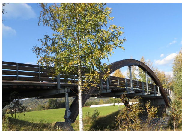
Rud bru i Nannestad. Foto: Statens vegvesen Region øst
