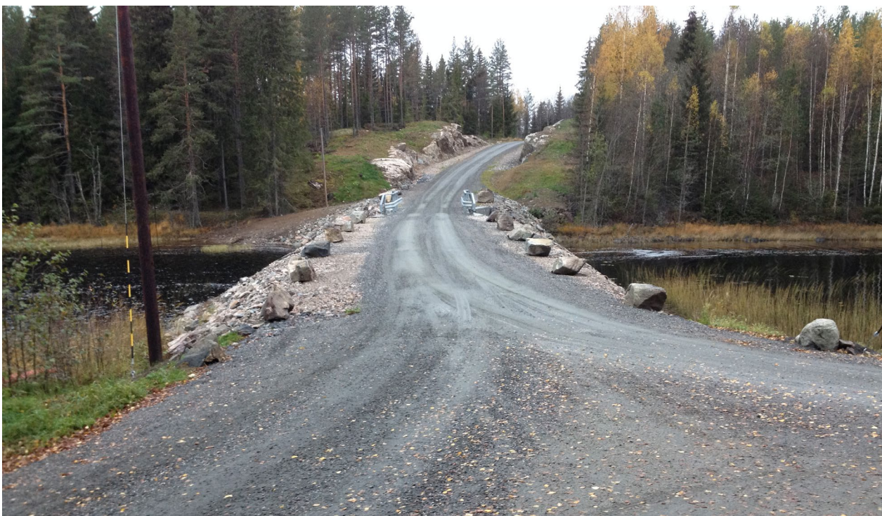
Sundbrua – Aurskog-Høland. Foto: Stian Sandbekkbråten
