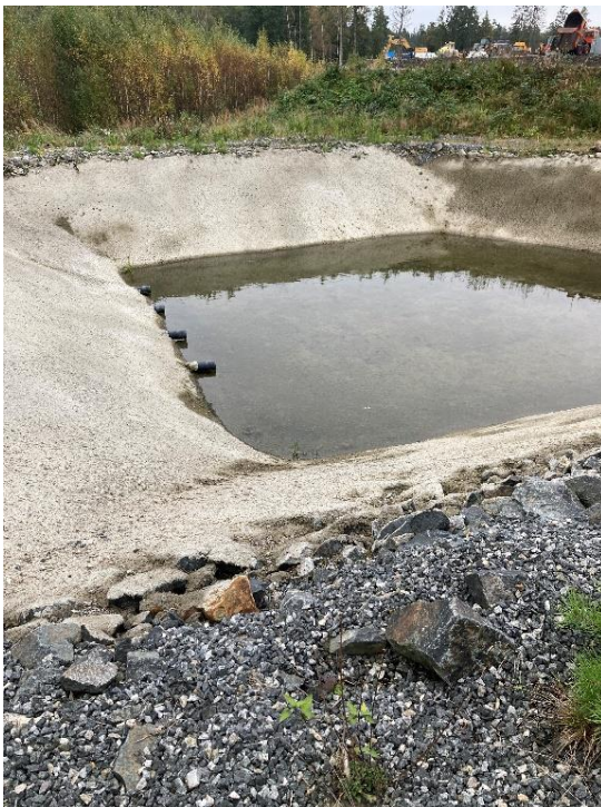
Figur 3-5. Bildene viser sedimentasjonsanlegg (til venstre) og tilstøtende biologisk rensetrinn (til høyre) som er under opparbeidelse i forbindelse med nytt næringsområde nedstrøms anlegget til Skolt. Foto: Multiconsult.
