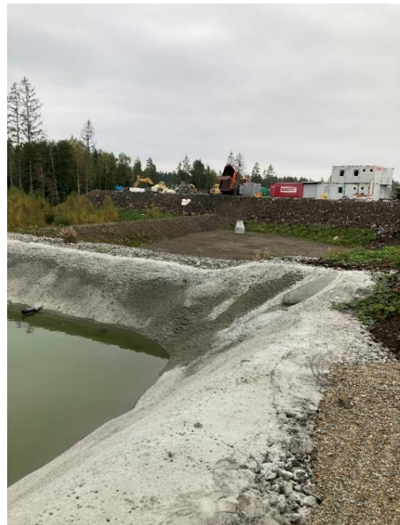
Figur 3-5. Bildene viser sedimentasjonsanlegg (til venstre) og tilstøtende biologisk rensetrinn (til høyre) som er under opparbeidelse i forbindelse med nytt næringsområde nedstrøms anlegget til Skolt. Foto: Multiconsult.
