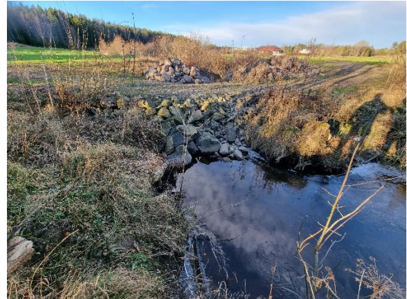
Nedre del av Vannembekken hvor det er anlagt en driftevei over steinfylling: Foto: Multiconsult.
