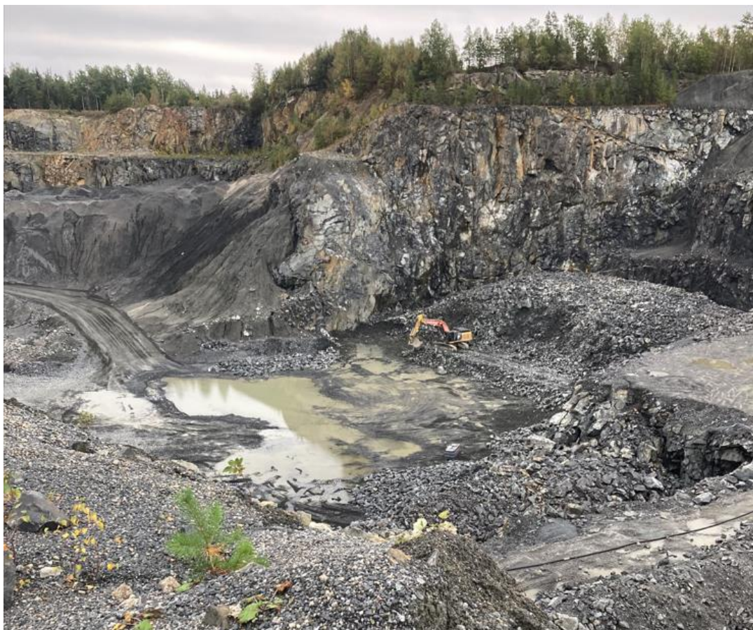
Figur 2-3. Overvann samles i bunnen på krateret før det pumpes opp i sedimentasjonsdam som vist i Figur 2-4. Foto: Multiconsult.
