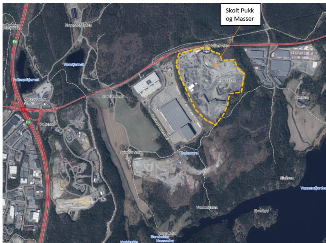
Figur 2-2. Flyfoto som viser Skolt Pukkverk ved Vålerveien i Moss. I nedre bildekant vises Mossesjøen og Vannemfjorden som utgjør en del av Vansjø. Kartkilde: Norgeskart.no
