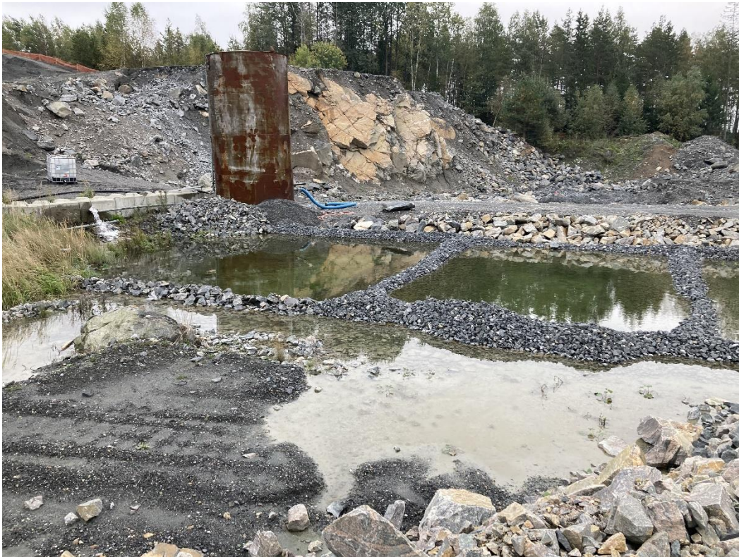
Figur 2-4. Sedimentasjonsdammer. Foto: Multiconsult
