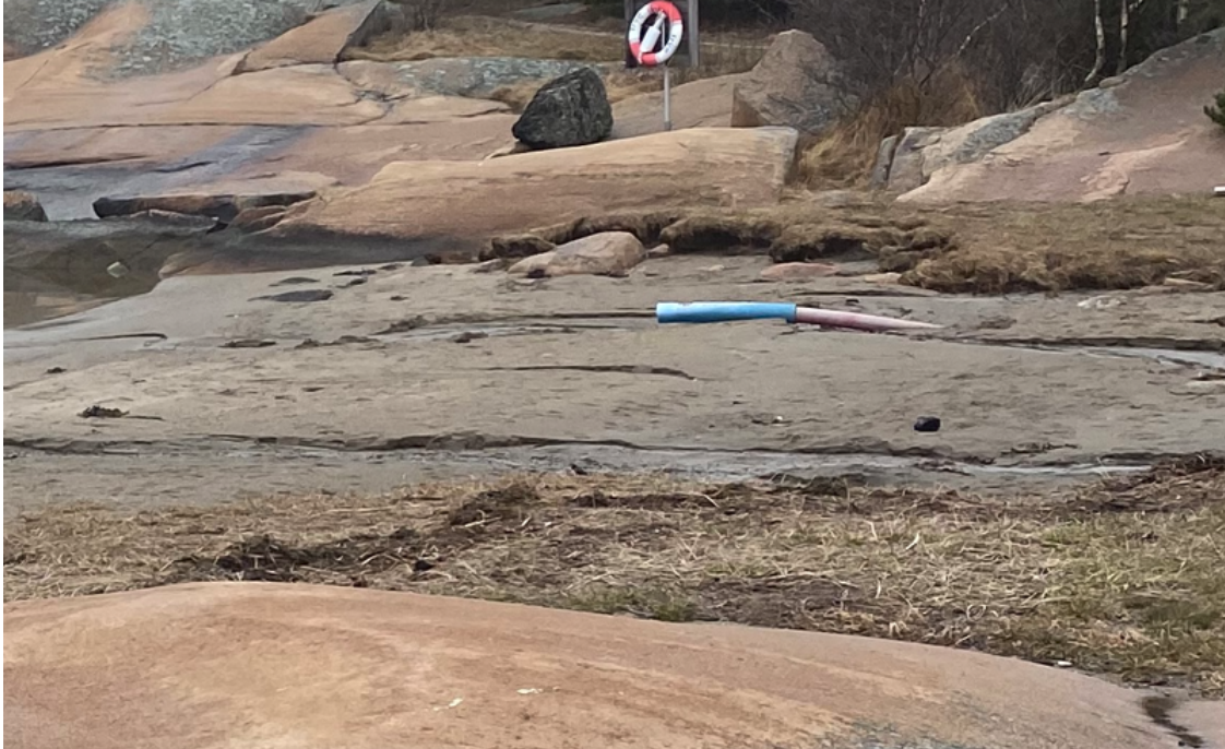
Figur 16: utløpet til overvannsrøret på Tangen badestrand.
