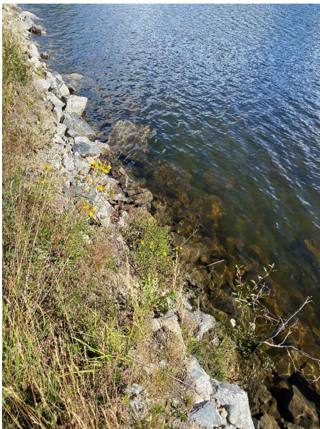
Figur 3. Vegfyllinga går heilt ut i vatnet langs store delar av vegen. Ute i vatnet er det lite til ingen vegetasjon.
