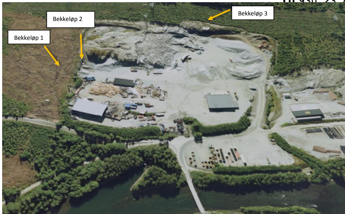
Figur 3 Skråfoto av industritomten sett fra nord mot sør. Alle de 3 flomløpene er synlige i terrenget (norgebilder.no).
