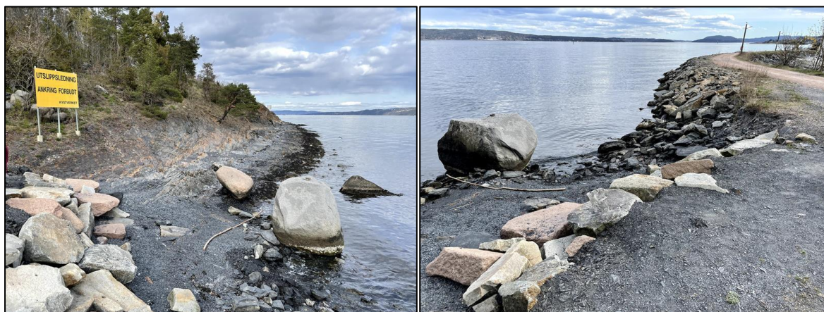
Figur 11. Bilder fra landtak ved Bjerkåsholmen der rørledning vil bli lagt. Dette er samme sted som for eksisterende Nærnes pumpeledning. Eksisterende ledning vil bli hensyntatt ved etablering av nye ledninger.
