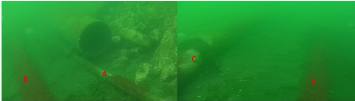
Figur 12. Bilder tatt under ROV-undersøkelser langs bunnen av steinmolo ved Bjerkåsholmen som viser eksisterende Nærnes rørledninger; rørledning A nærmest molo, B i midten og C lengst øst. Mellom rørledning A og molo ligger det et sylinderformet objekt som kan være enden på et større rør. Rørledningene filmet 11.05.2022 (Rambøll, 2022).
