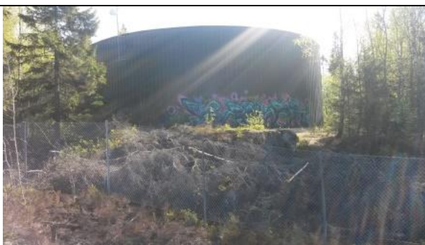
Øst for steinbruddet er det et kommunalt høydebasseng for drikkevann.
