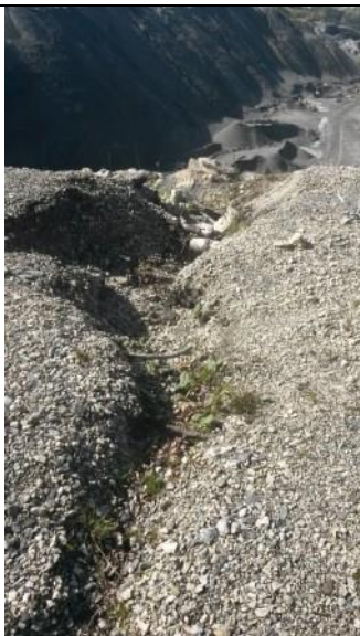
Avrenning av overvann nord i bruddet
