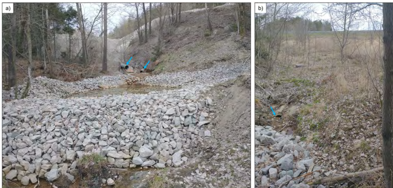
Figur 26 Områdedrenering skjer til sedimentasjons dam i nordøst. Videre drenering går i rør under E6.
