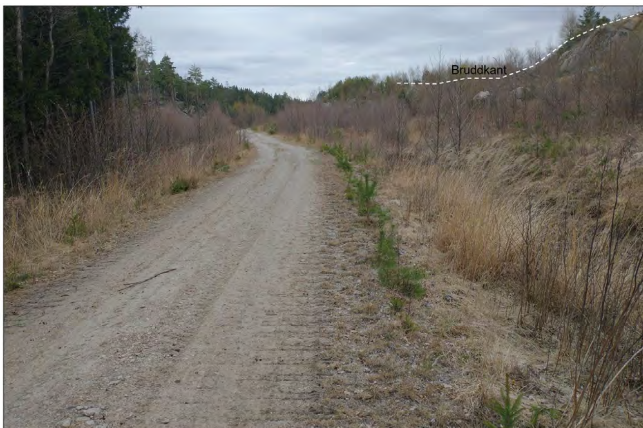
Figur 23 Vestlig deponi er gitt ved en vesentlig forsenkning i terrenget like i bakkant av dagens bruddkant. Forsenkningen er isolert og omgitt av høydedrag og bergknauser og vil derav ikke utgjøre en fare for områdestabiliteten.
