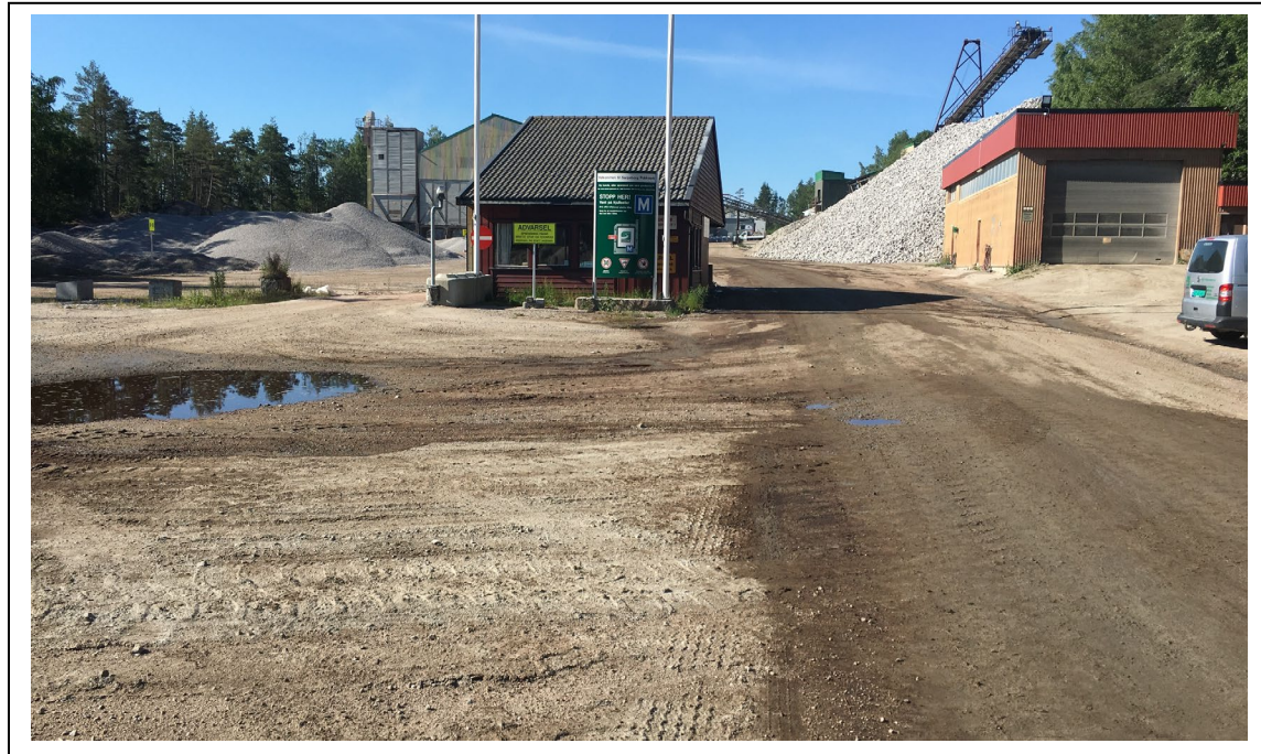
Figur 9: Foto av adkomst med vekt, kontrollbu og driftsområde ved Sarpsborg pukkverk.
